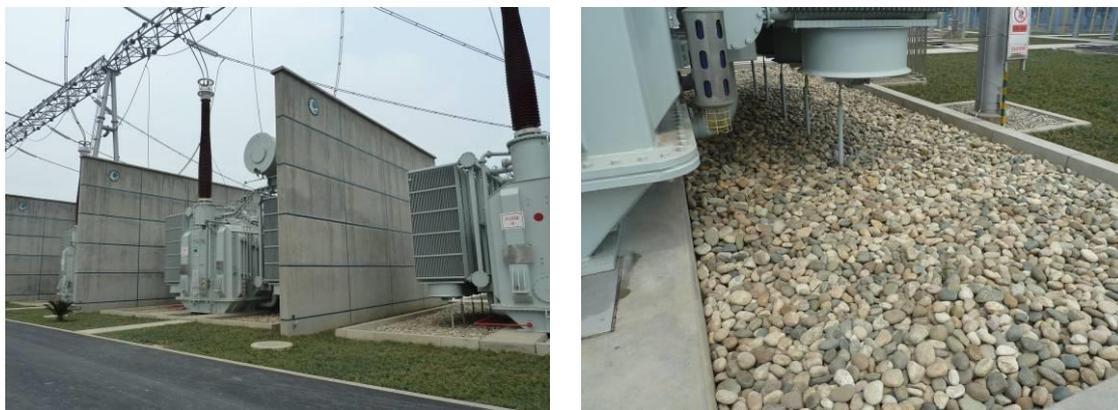
图 11-1 变电站事故油坑
