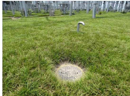
主变事故油池
