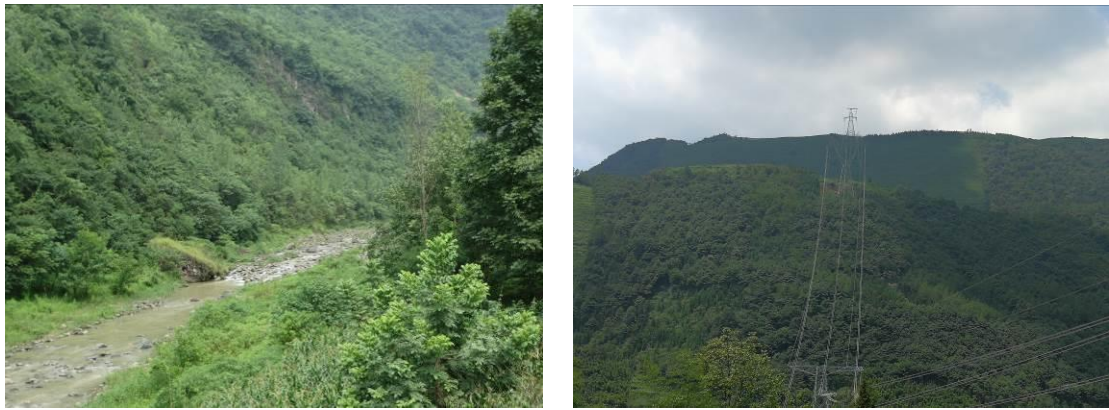
图 9-1 线路跨越地表水体
