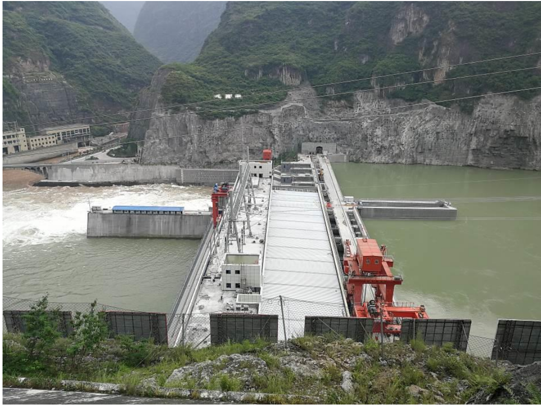
图 3-6 沙坪二级电站升压站
