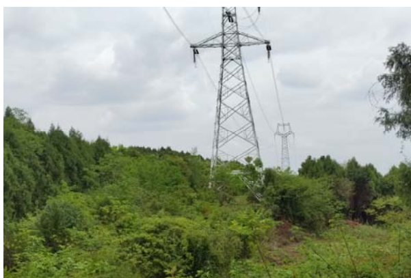
图 2.6-3 林地、草地塔位现状
