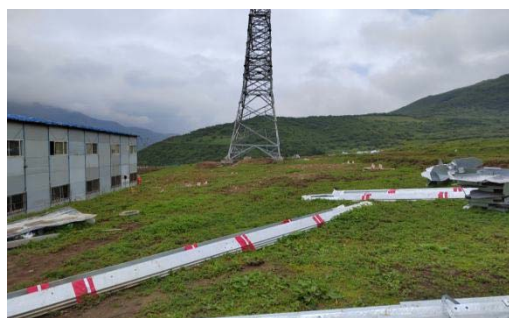
相岭-蓼坪 J229 号塔基施工场地平整恢复植被
