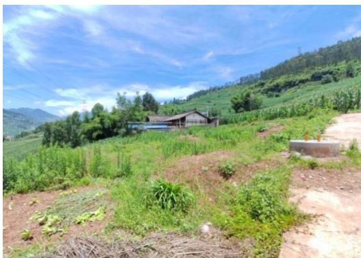
尔足-蓼坪 JB4 号铁塔临时拦挡
