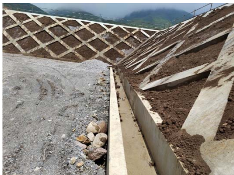
进站道路排水沟及护坡 1
