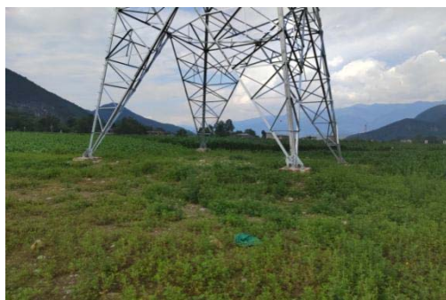
相岭-蓼坪 N101 号塔基施工场地现状
