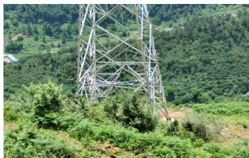
相岭-蓼坪 J222 号塔基施工场地现状
