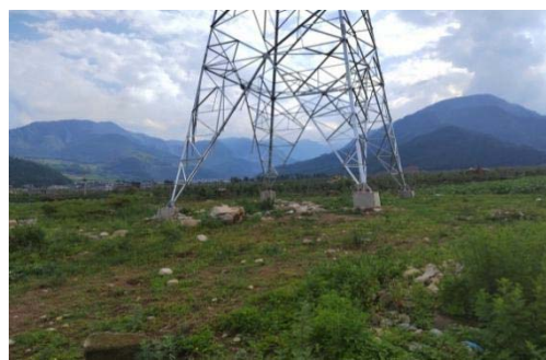
相岭-蓼坪 J201 号塔基施工场地现状
