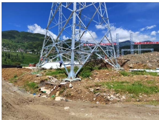
蓼坪-甘洛南 JA0 号塔基施工场地现状
