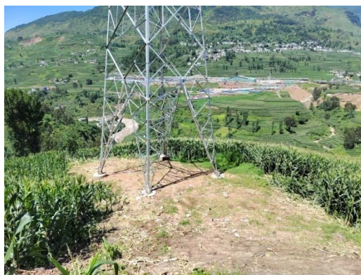
蓼坪-甘洛南 JA2 号塔基施工场地现状
