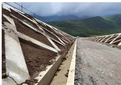
进站道路排水沟及护坡 2
