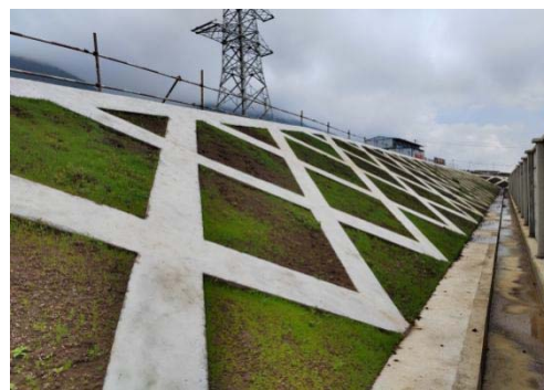
开关站站外框架植草皮护坡
