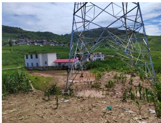
尔足-甘洛南 J9 号铁塔塔基施工场地复耕
