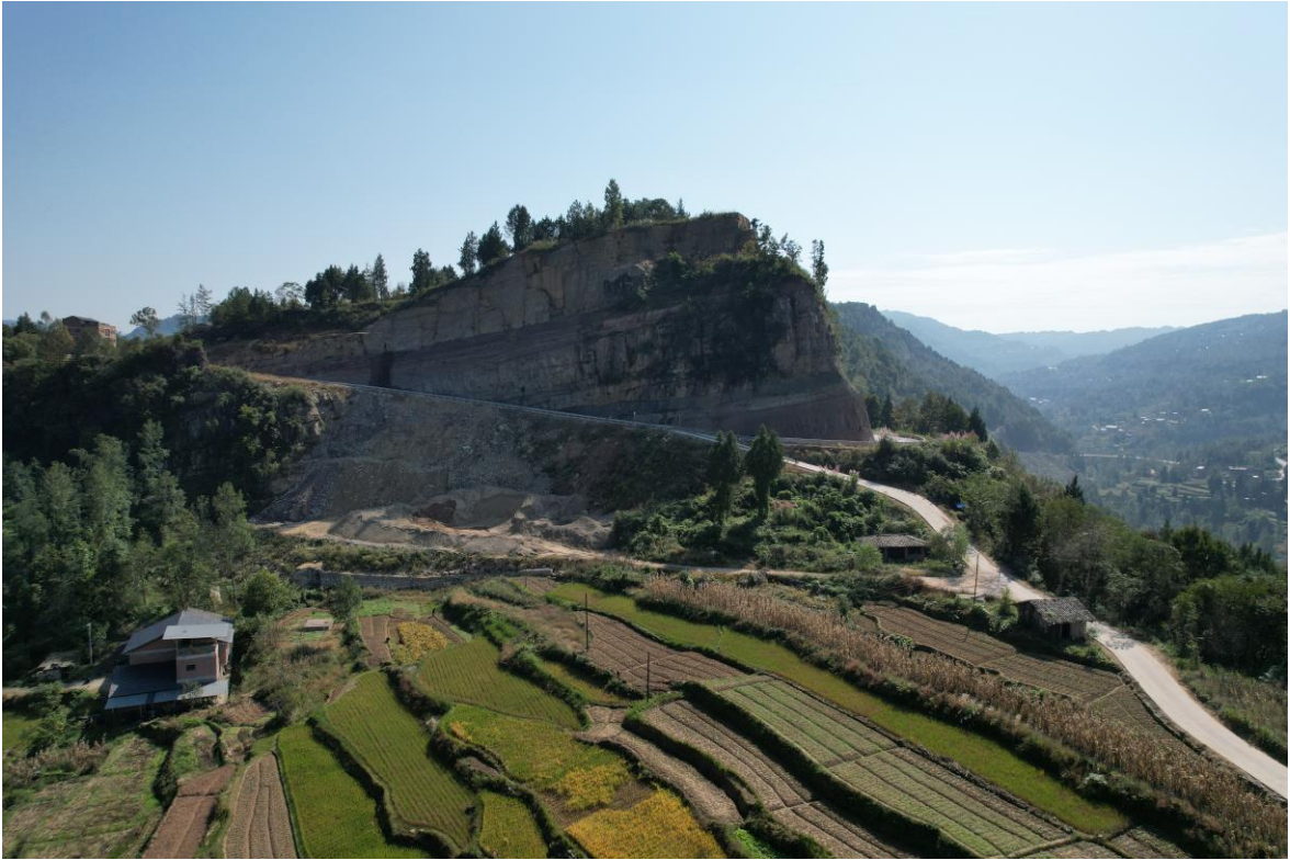
红峰 35kV 变电站进线方向情况
