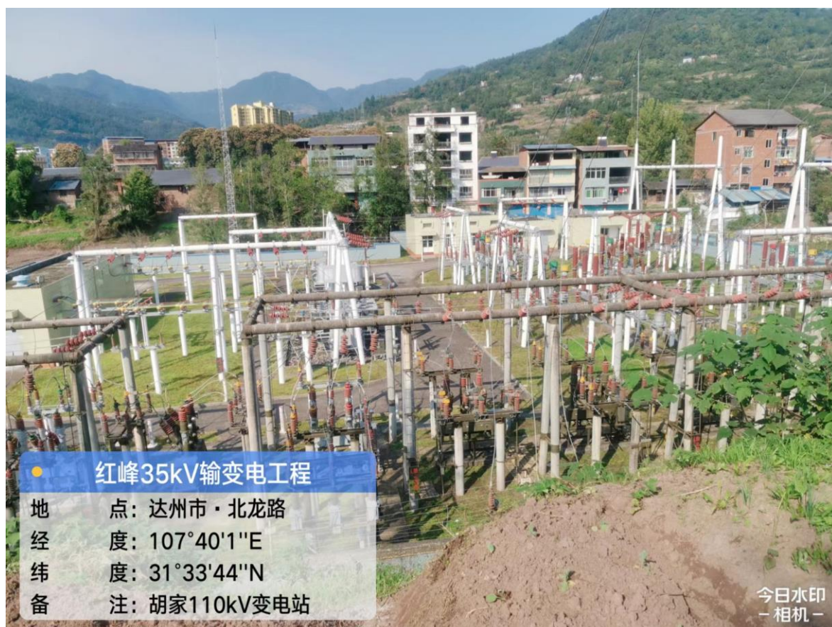
胡家 110kV 变电站 35kV 出线间隔
