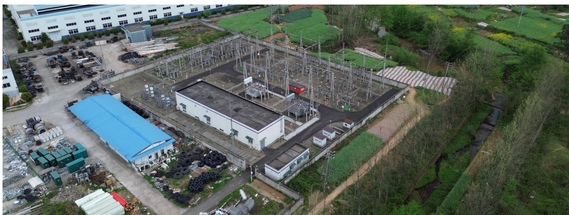
桂花 110kV 变电站现状图
