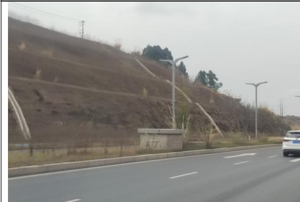
(7) 市政管廊现状
