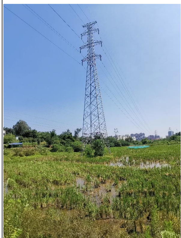
N1 塔位、110kV 玉新三线 13#塔 (拆除)
