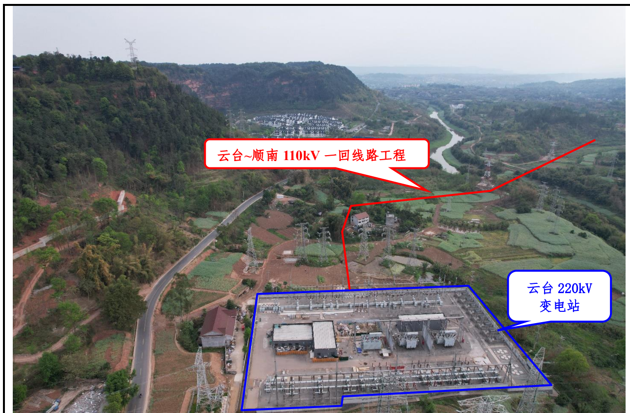
云台~顺南 110kV 一回线路工程架空线路出线
