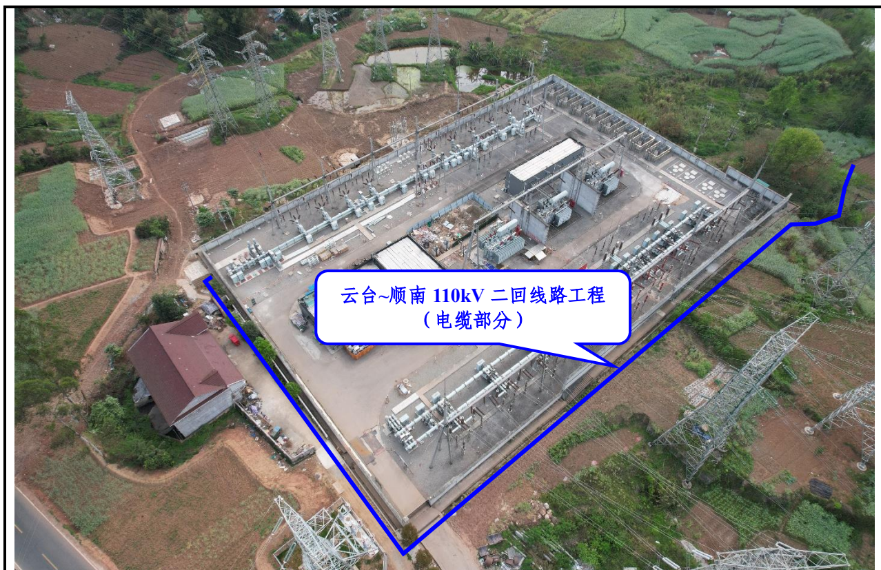
云台~顺南 110kV 二回线路工程电缆路径
