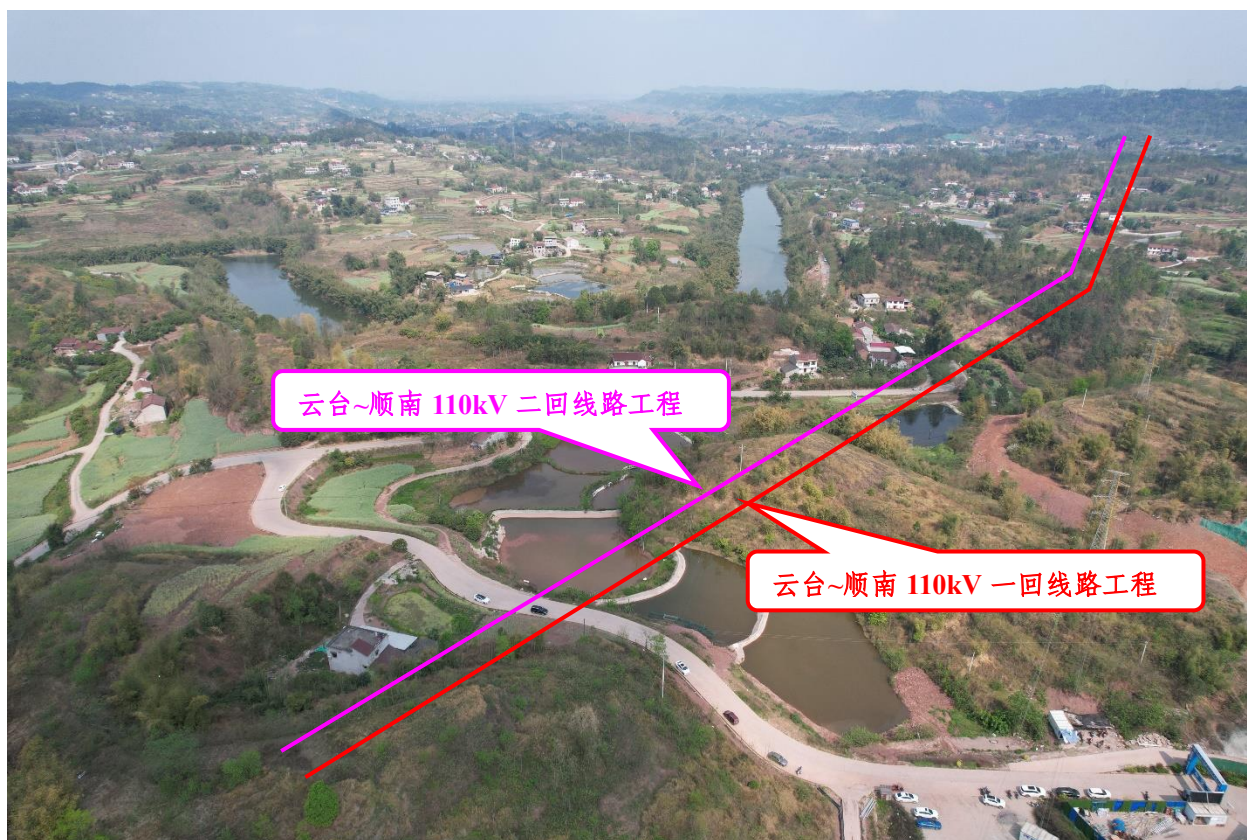
云台~顺南 110kV 线路工程唐家湾附近沿线情况
