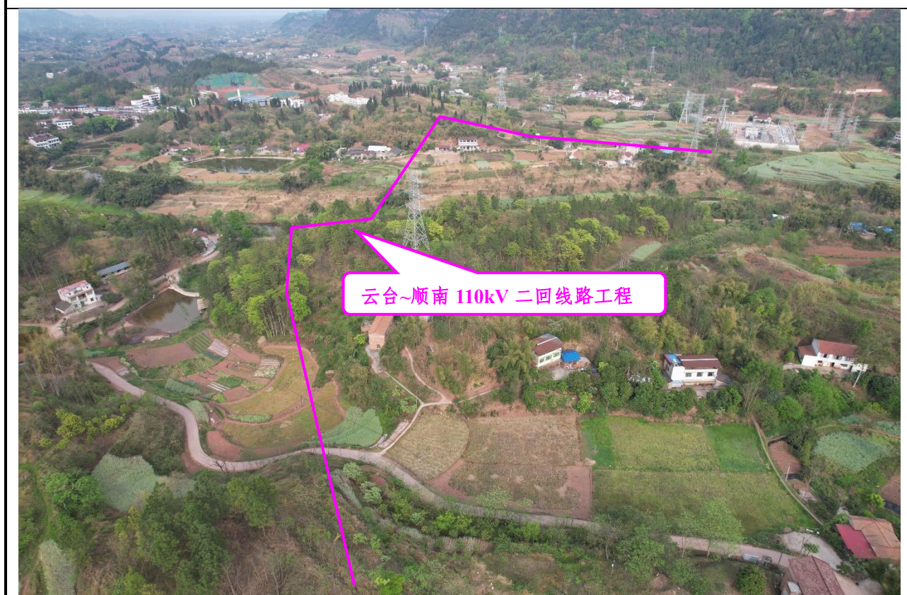
云台~顺南 110kV 二回线路工程老院子附近沿线情况
