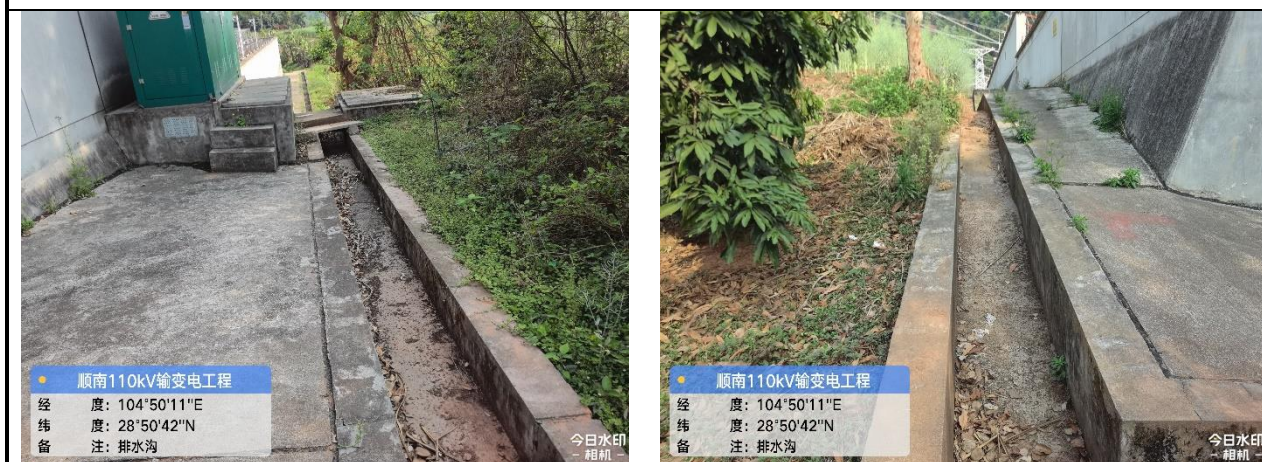
云台 220kV 变电站站外排水沟
