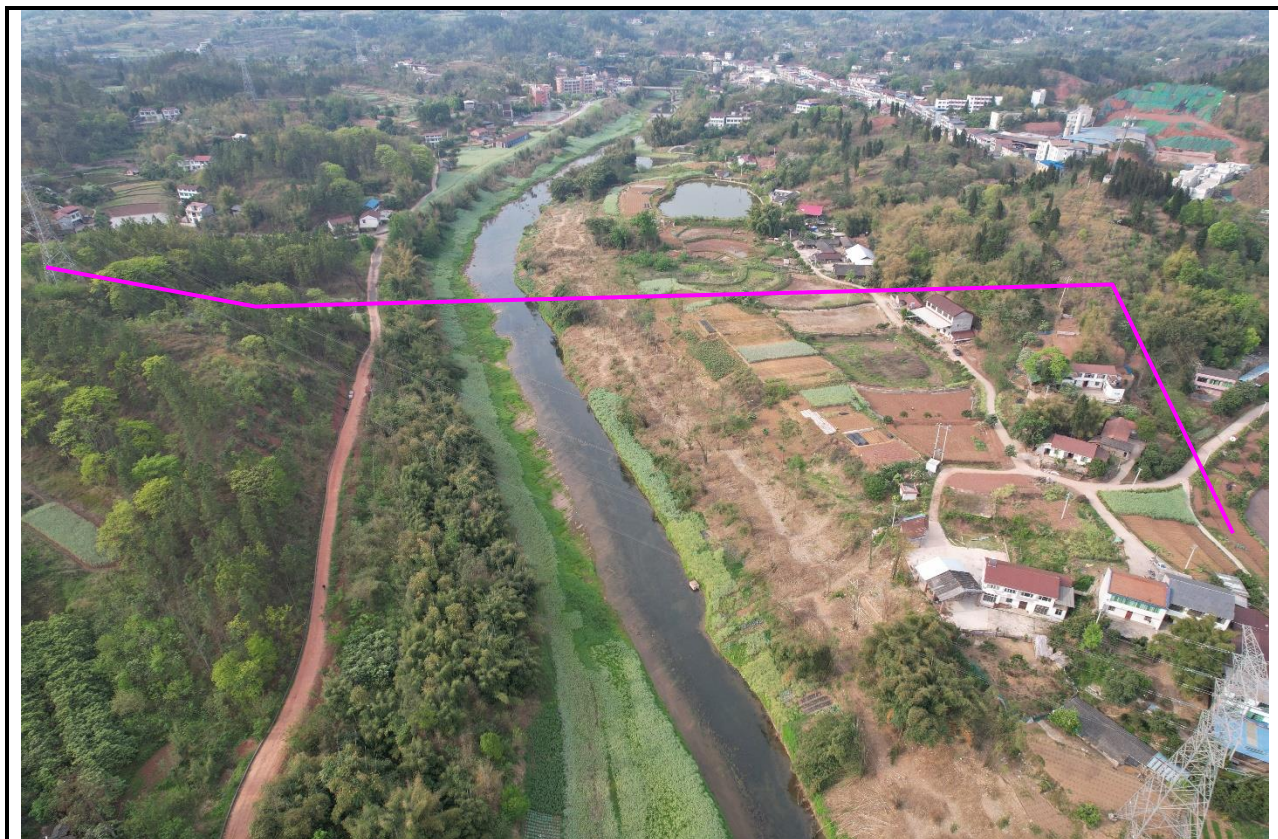
云台~顺南 110kV 二回线路工程跨越黄沙河
