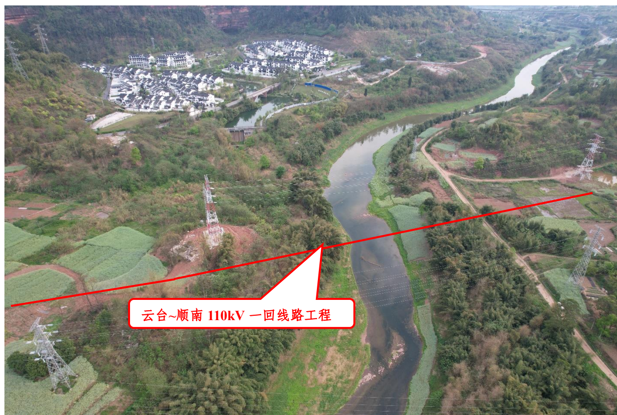
云台~顺南 110kV 一回线路工程跨越黄沙河
