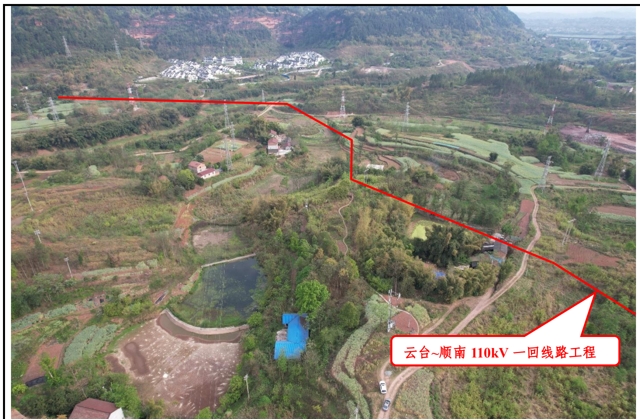
云台~顺南 110kV 一回线路工程骑马山附近沿线情况
