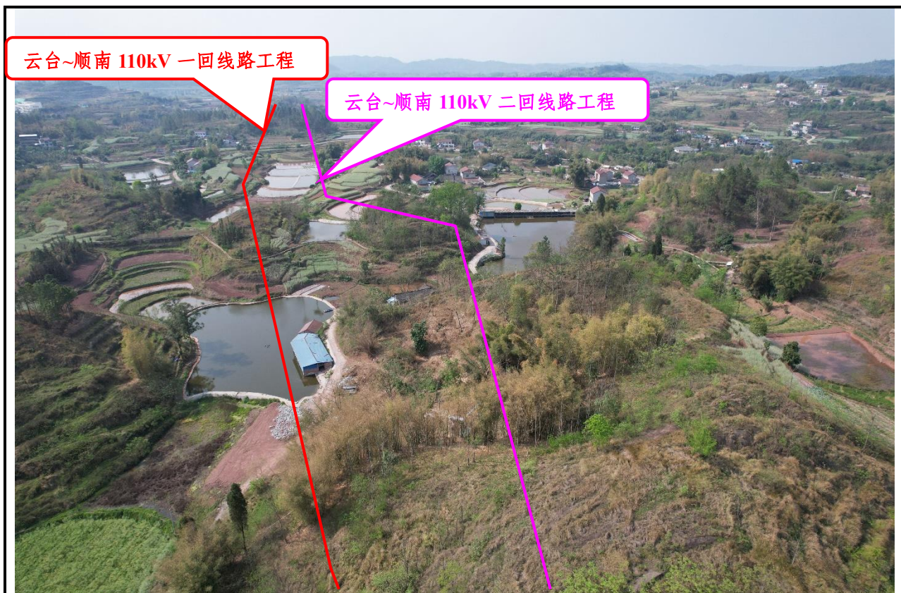
云台~顺南 110kV 线路工程桂花湾附近沿线情况
