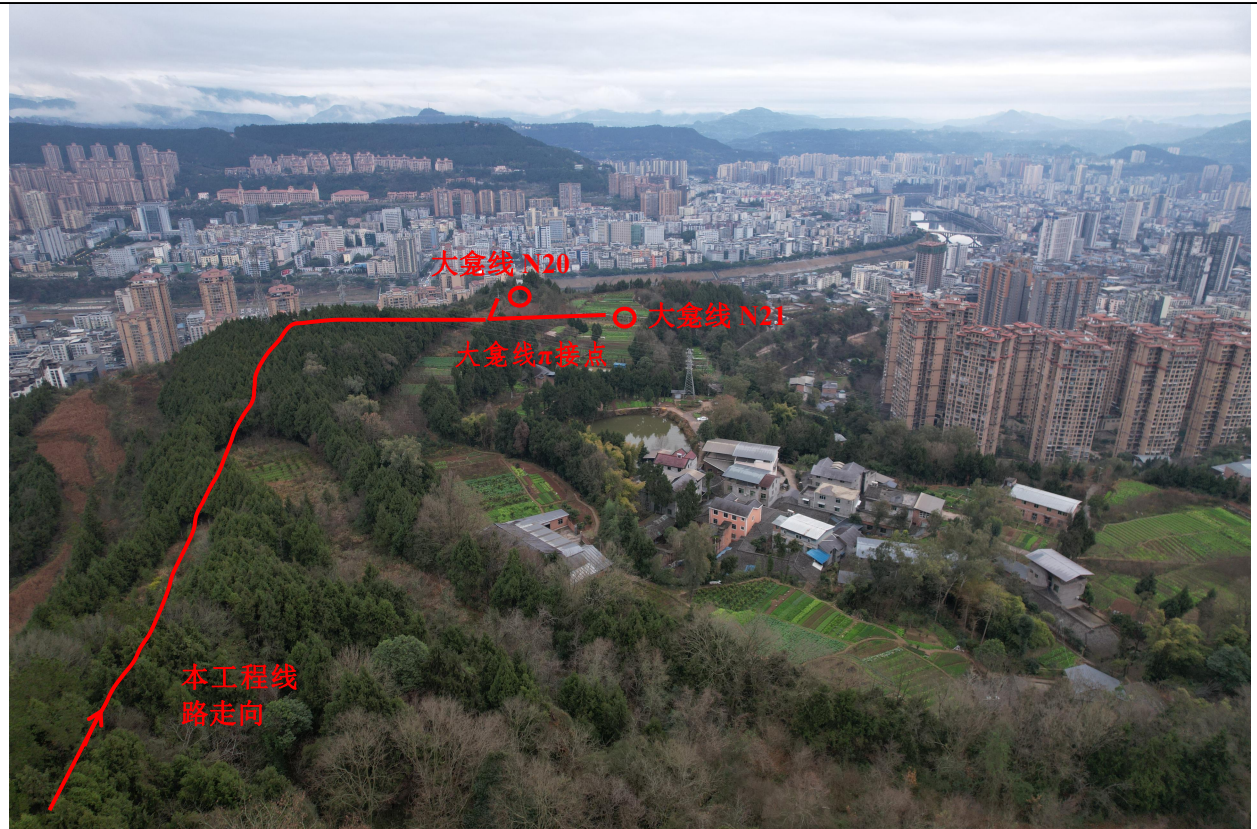
大龛线 \pi 入莲山湖变 35kV 线路沿线地形地貌及植被
