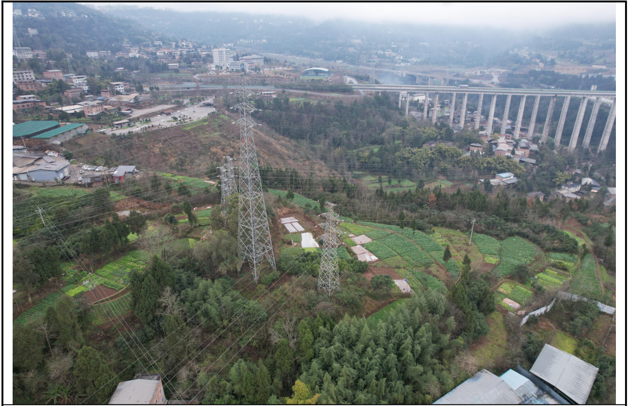
大龕线改接堂城线处现状
