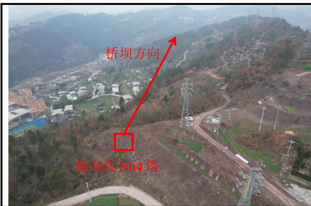
集州 110kV 变电站出线沿线地貌及植被
