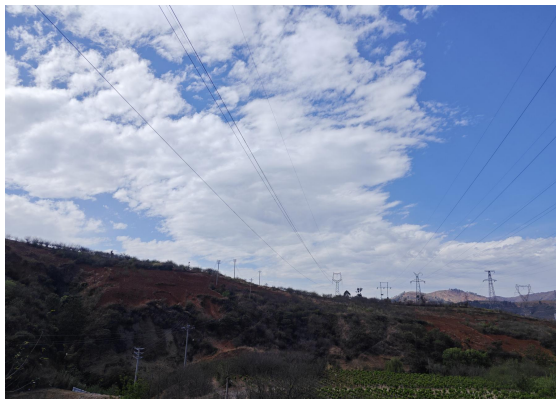
沿线地形地貌照片
