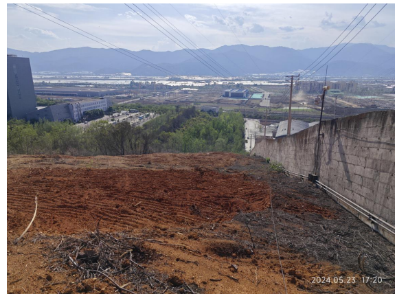
沿线地形地貌照片
