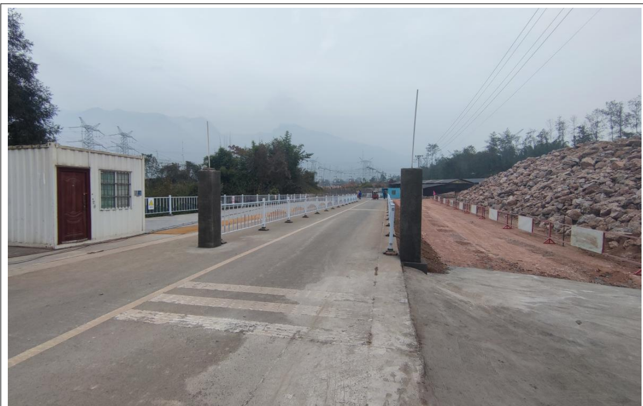
场地出入口现状
