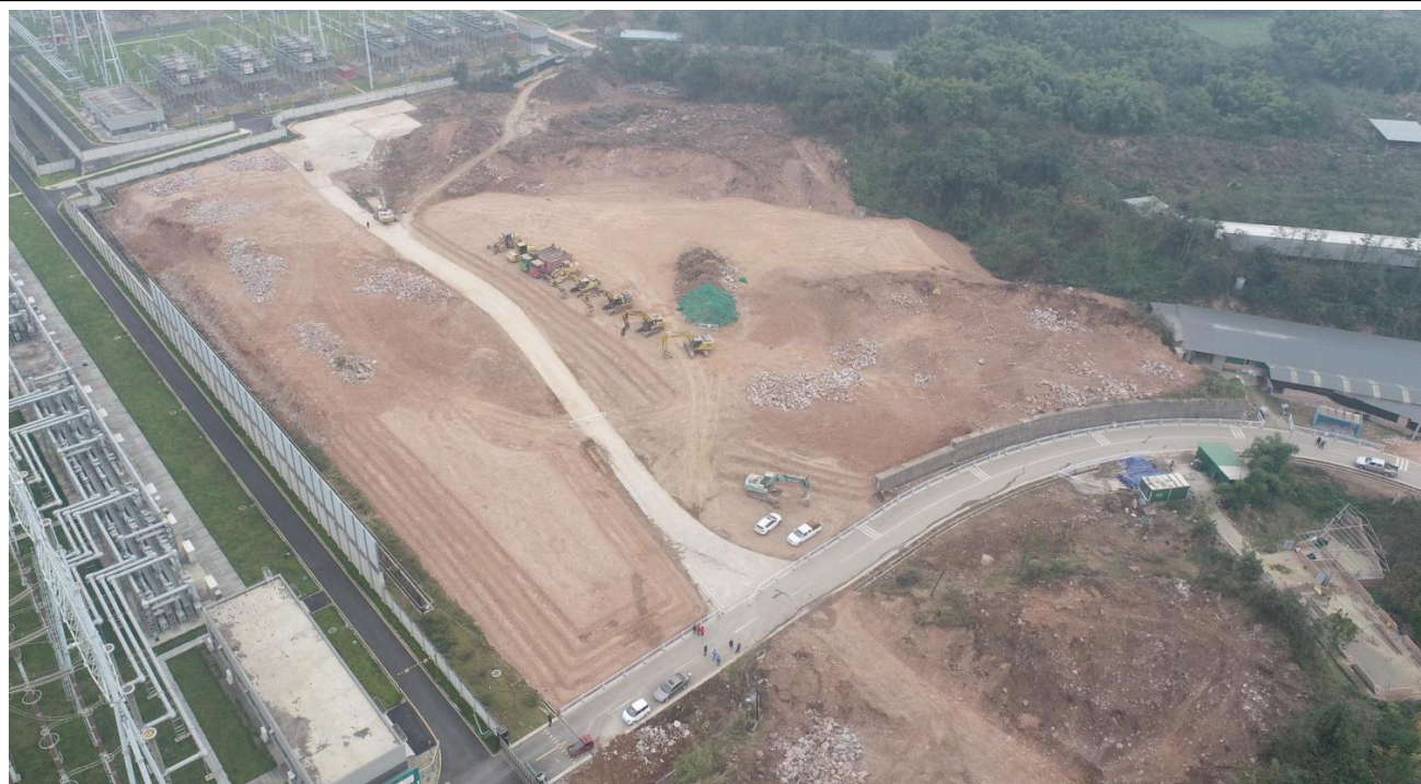
开关站扩建工程区场平现状
