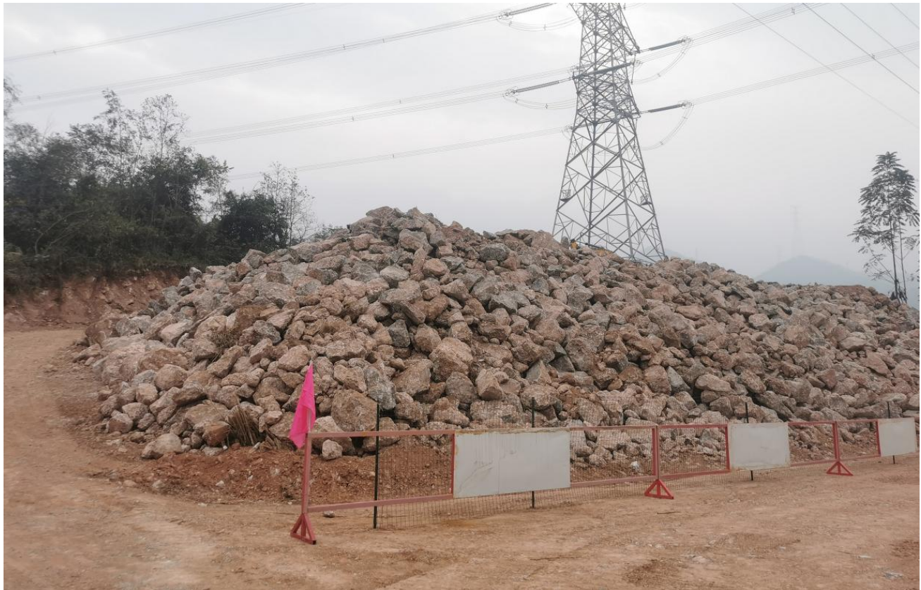
石方临时堆放场现状
