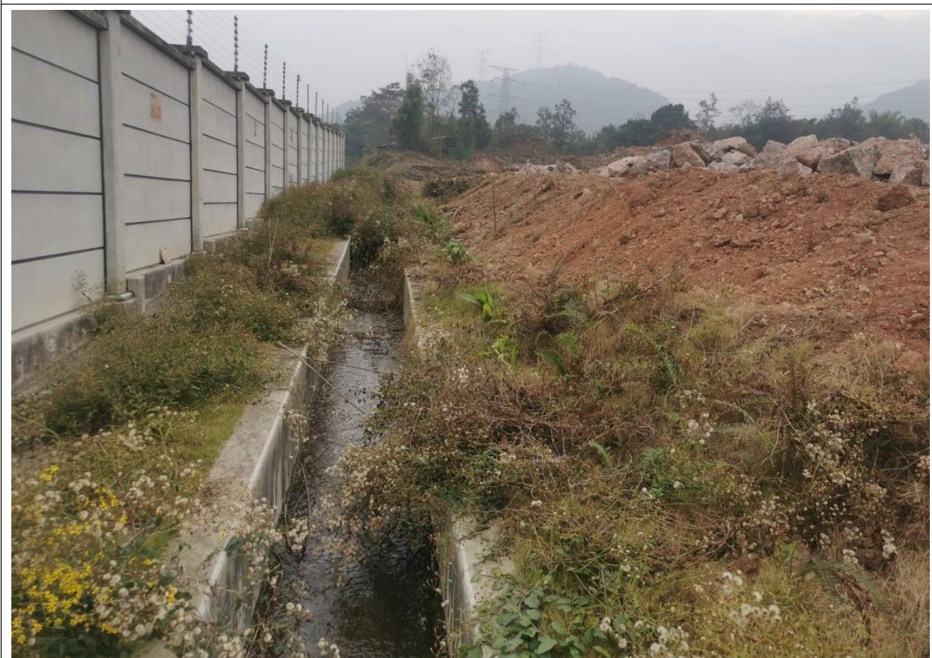
原开关站周边现有排洪沟
