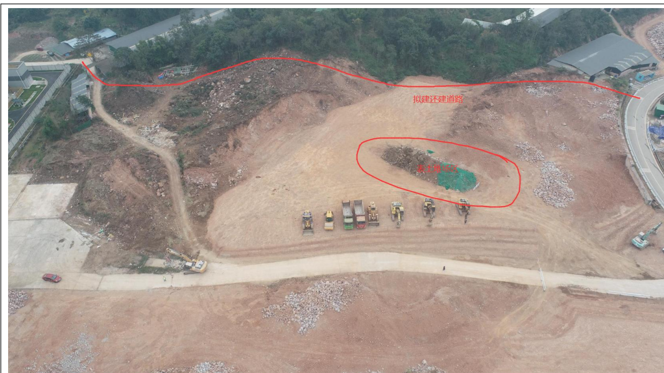
拟建还建道路和暂存表土堆场
