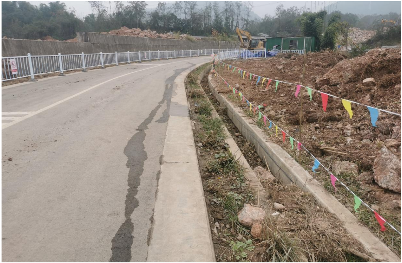
原进站道路及道路边沟
