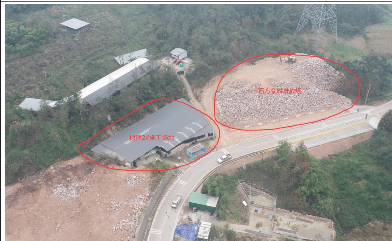
拟建施工场地（征地中）和新增石方临时堆放场现状
