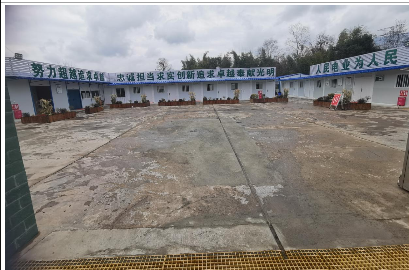
1#施工场地现状地面硬化，周边设排水沟
