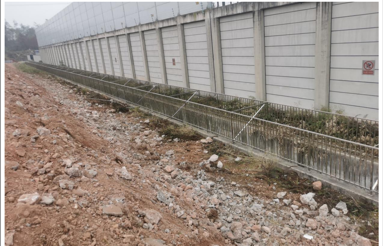
原开关站周边现有排洪沟
