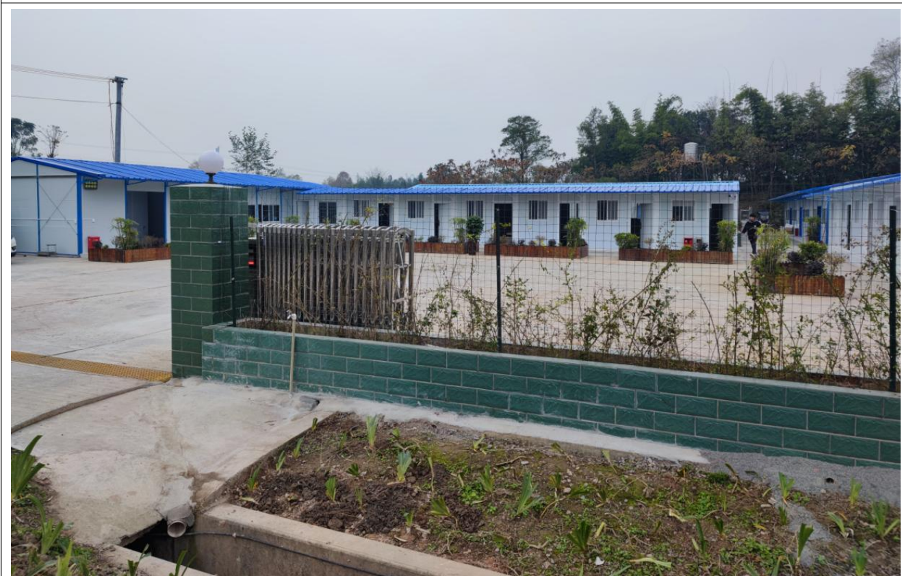
1#施工场地现状
