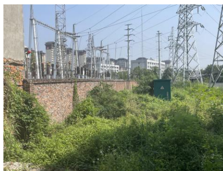
变电站南侧围墙外
