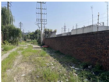
变电站北侧围墙外
