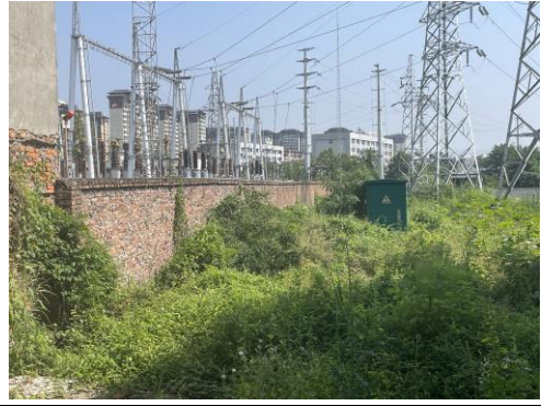
图 11 金江 110kV 变电站南侧现状
