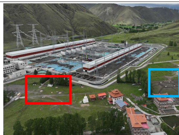
A1 (红色区域, 已开挖未浇筑)、B1 (已浇筑) 施工现状
