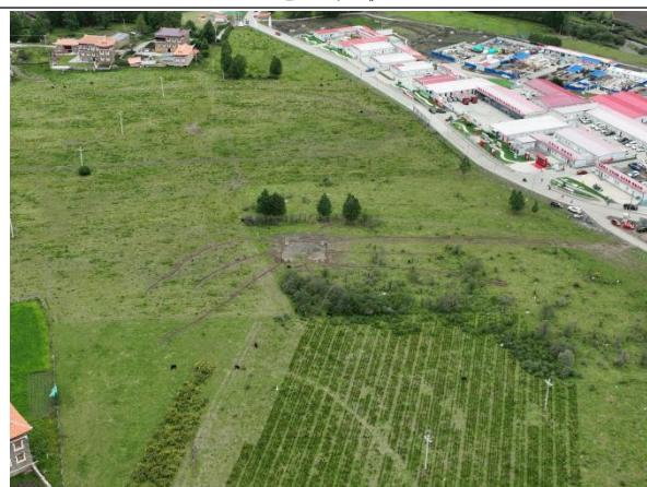
B3 施工现状 (已浇筑)
