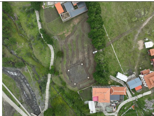
B2 施工现状 (已浇筑)
