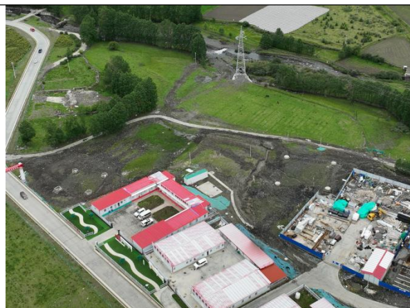
A2 (右)、B4 (左) 施工现状 (已浇筑)
