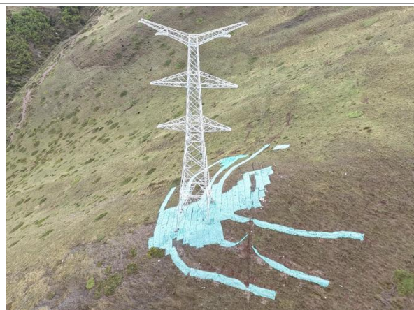
N6 建设现状
