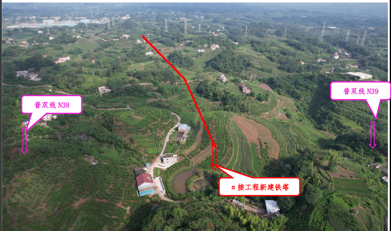
普双线“π”入双龙 35kV 线路 38 号侧接点情况
