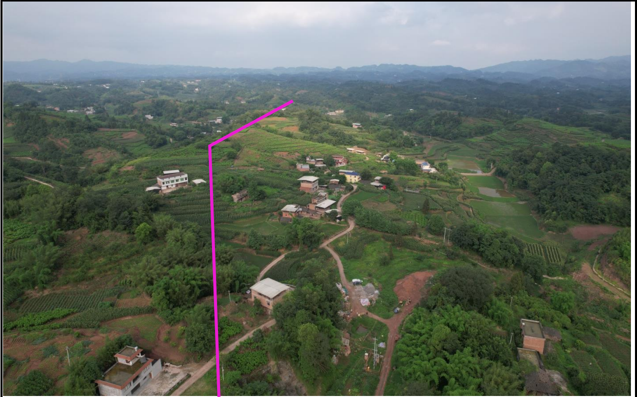
普双线“π”入双龙 35kV 线路 44 号侧沿线情况
