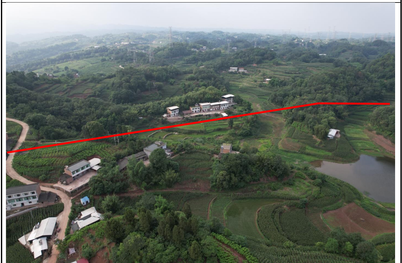
横江~双龙 35kV 线路新建工程双槽水库附近情况
