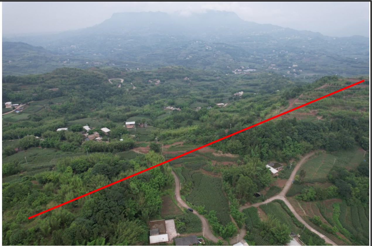
横江~双龙 35kV 线路新建工程三教堂（横江侧）沿线情况
