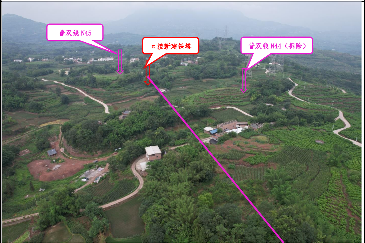
普双线“π”入双龙 35kV 线路 44 号侧沿线情况
