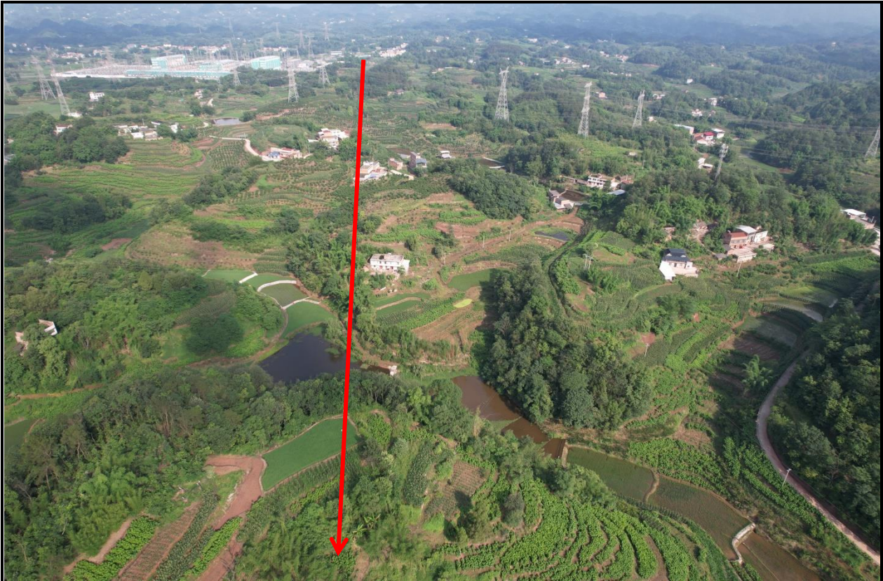
普双线“π”入双龙 35kV 线路 38 号侧沿线情况
