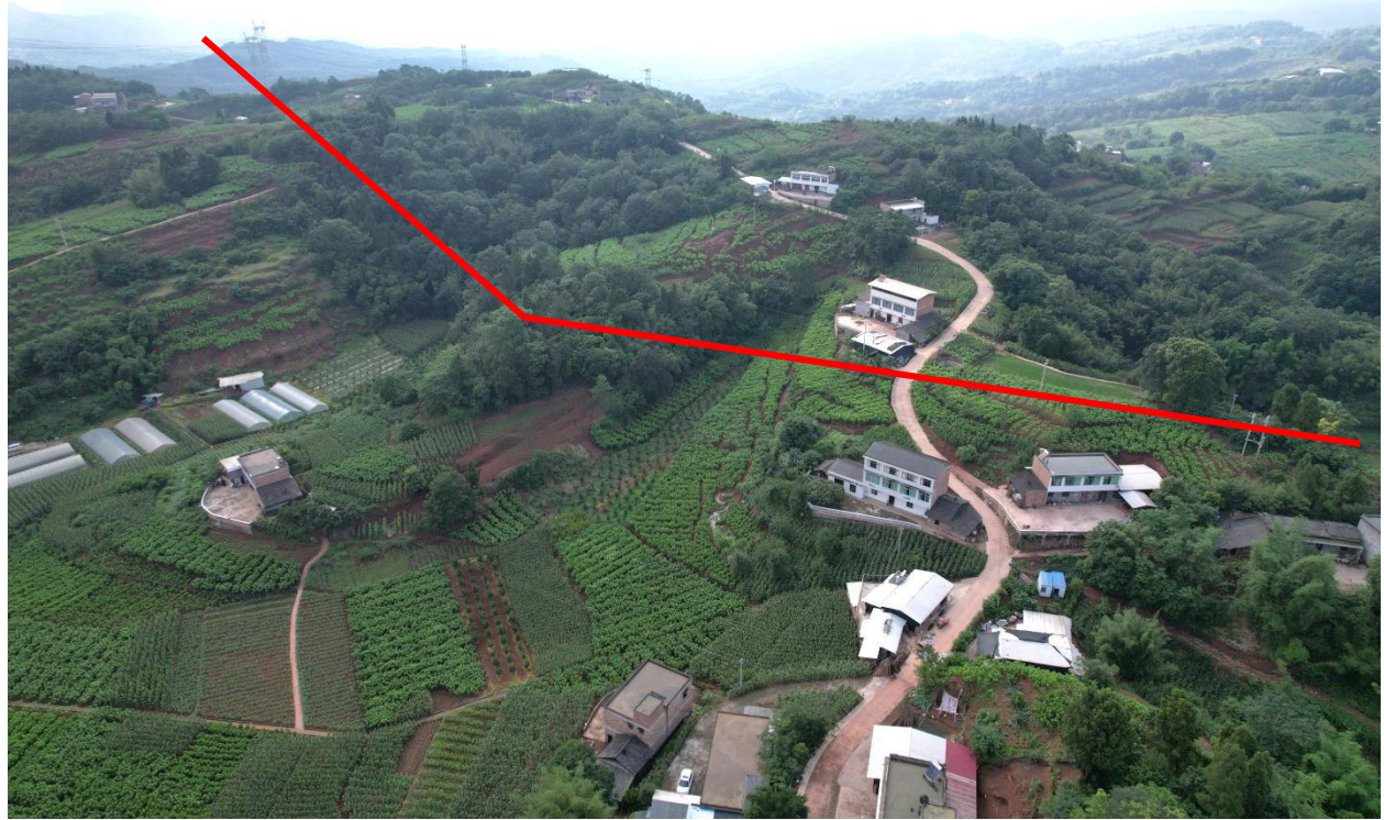
横江 ~ 双龙 35kV 线路新建工程沙湾沿线情况
