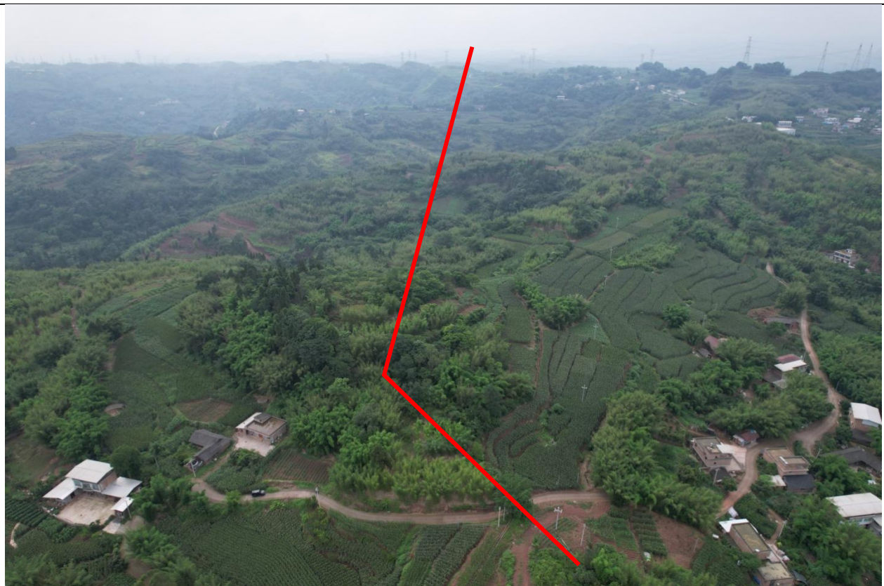
横江 ~ 双龙 35kV 线路新建工程三教堂（双龙侧）沿线情况
