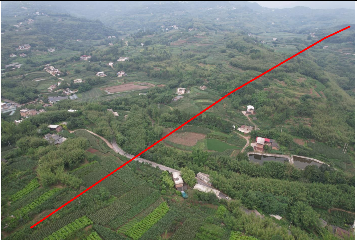
横江~双龙 35kV 线路新建工程三道溪沿线情况
