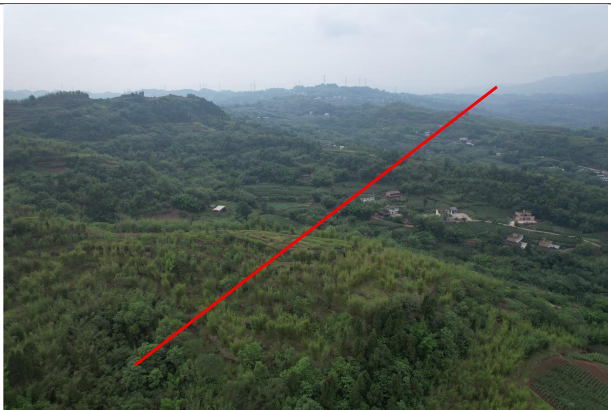
横江~双龙 35kV 线路新建工程谢家湾沿线情况
