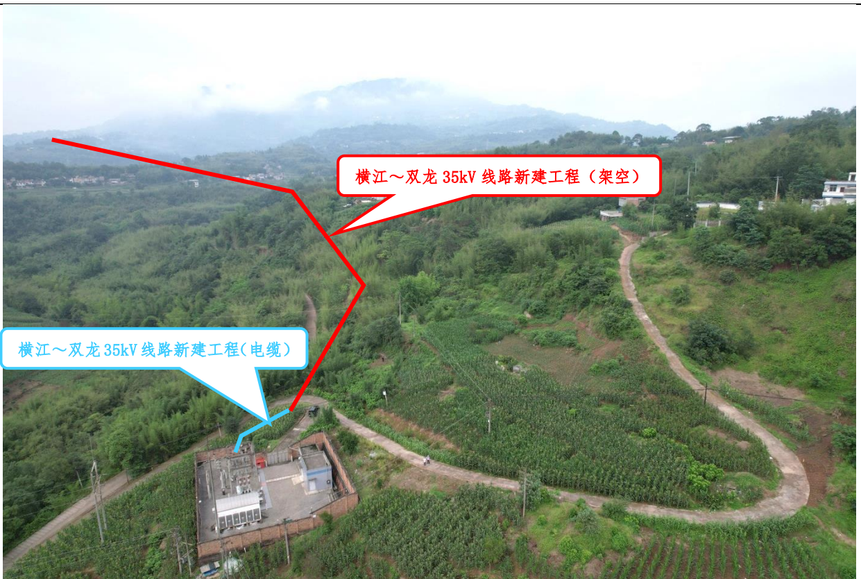
横江~双龙 35kV 线路新建工程沿线情况
