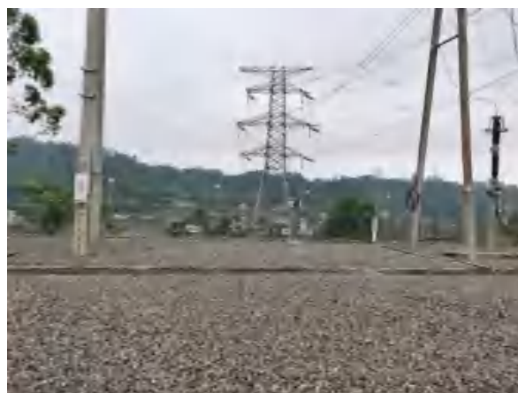
屏山 220kV 变电站扩建 220kV 出线间隔工程现场照片 (6)
