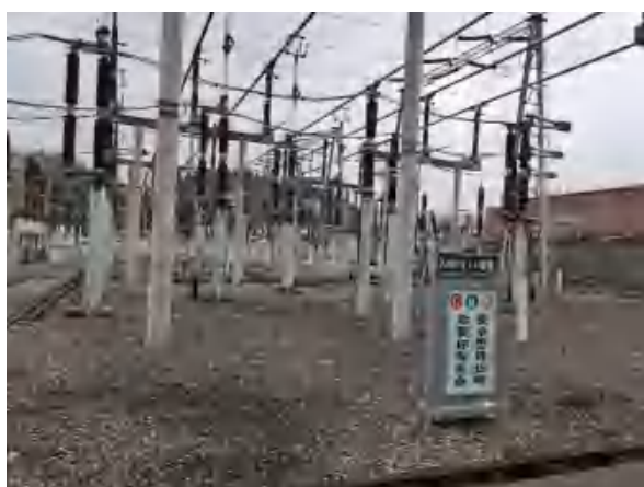
屏山 220kV 变电站扩建 220kV 出线间隔工程现场照片 (3)
