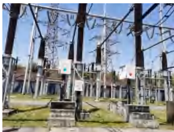
叙府 500kV 变电站扩建 220kV 出线间隔工程现场照片 (4)
