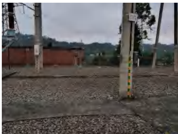
屏山 220kV 变电站扩建 220kV 出线间隔工程现场照片 (5)
