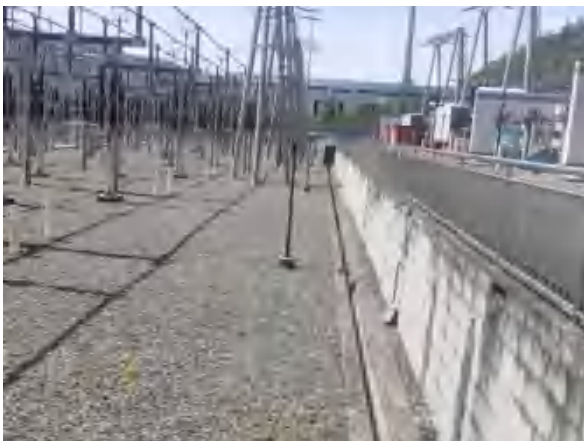
豆坝 220kV 变电站内部排水沟
