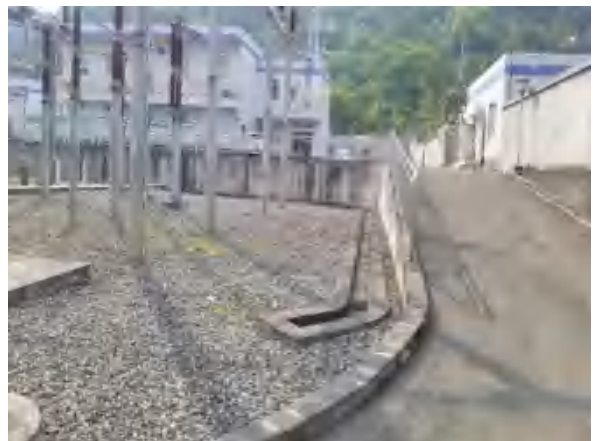
豆坝 220kV 变电站场内排水沟
