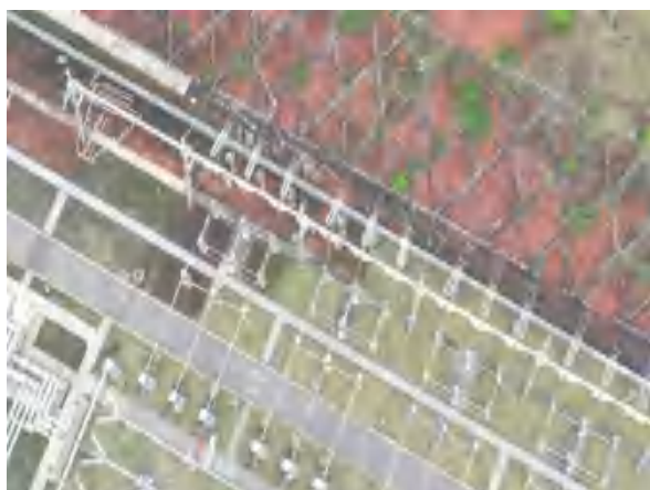
叙府 500kV 变电站扩建 220kV 出线间隔工程现场照片 (1)
