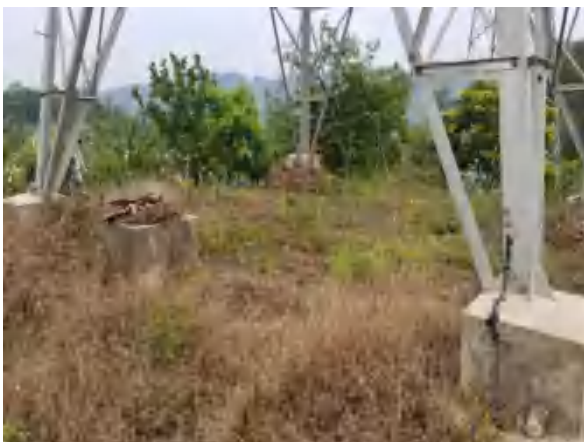
丰屏线、丰盛线II段 006 号老豆坝火电线路拆除
