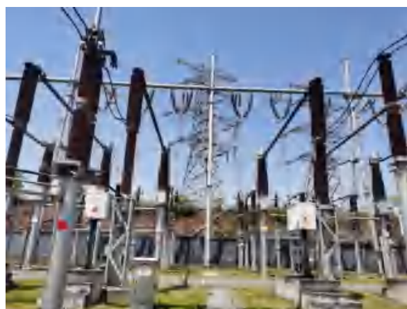
叙府 500kV 变电站扩建 220kV 出线间隔工程现场照片 (2)
