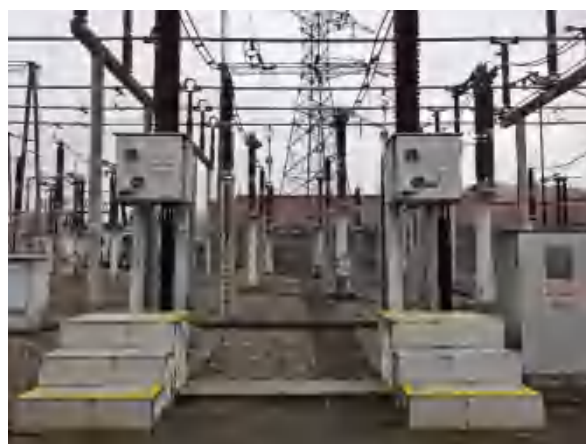
屏山 220kV 变电站扩建 220kV 出线间隔工程现场照片 (2)
