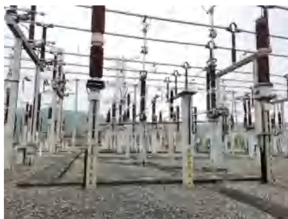
屏山 220kV 变电站扩建 220kV 出线间隔工程现场照片 (4)
