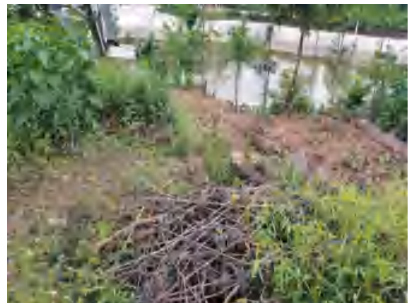
丰屏线、丰盛线II段 005 号下部设置的排水沟
