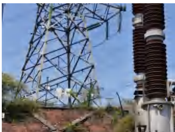
叙府 500kV 变电站扩建 220kV 出线间隔工程现场照片 (3)
