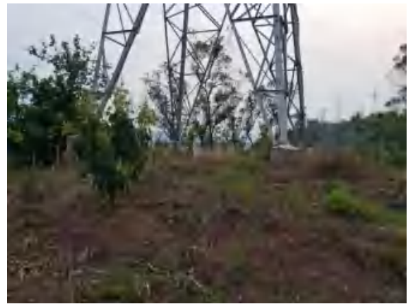
丰屏线、丰盛线II段 006 号塔基下部平整绿化
