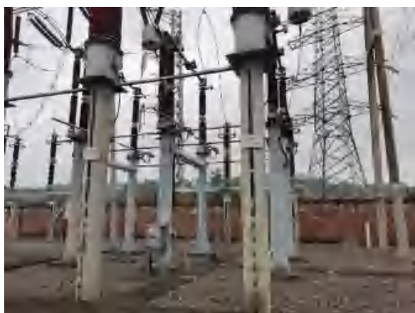
屏山 220kV 变电站扩建 220kV 出线间隔工程现场照片 (1)
