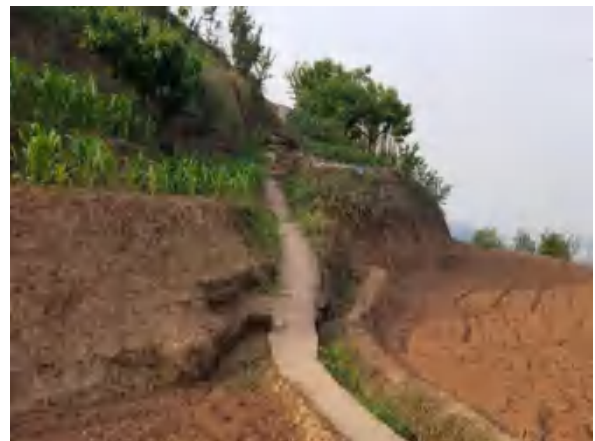
丰铁线 002 号施工道路
