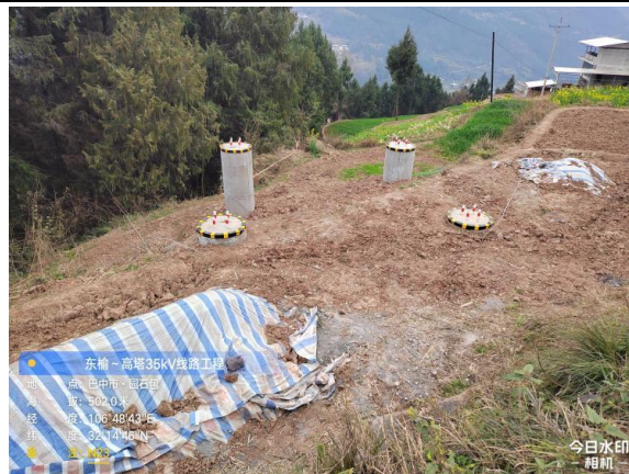
N23塔表土剥离、表土回覆、堆料铺垫塑料布
