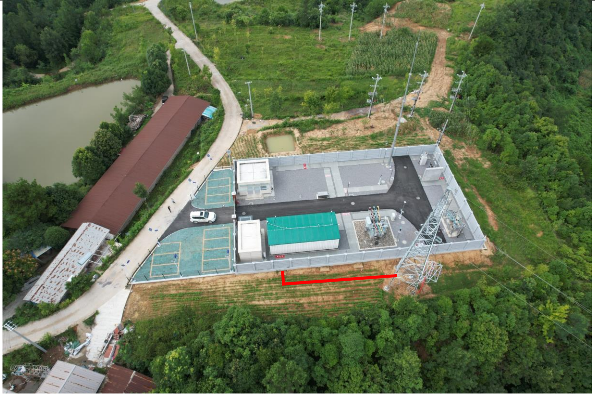
高塔 35kV 变电站侧电缆（复耕）
