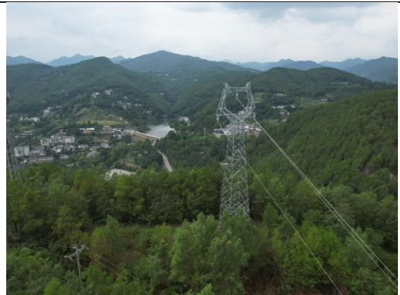
N57 塔 (恢复植被)
