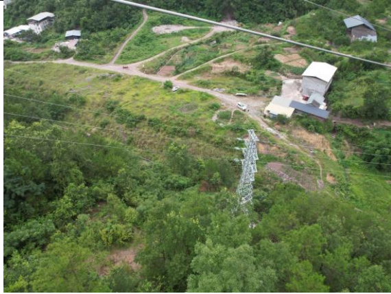
N62 塔 (恢复植被)
