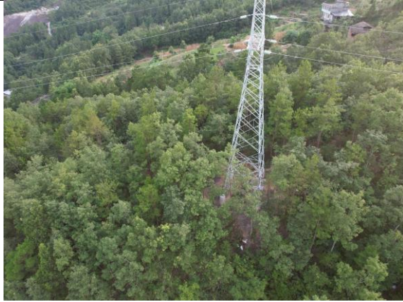
N46 塔 (恢复植被)
