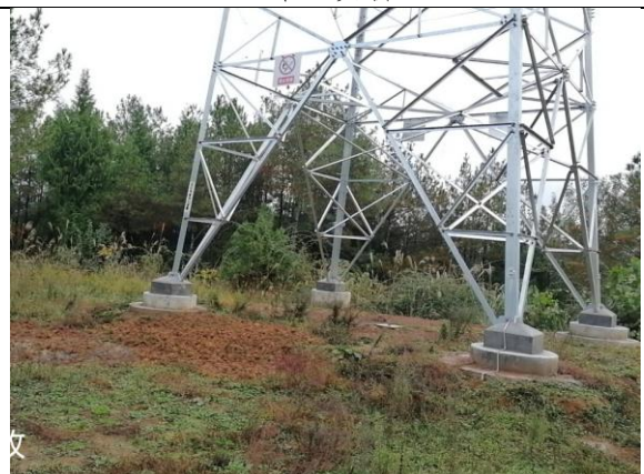
N11塔 (恢复植被)
