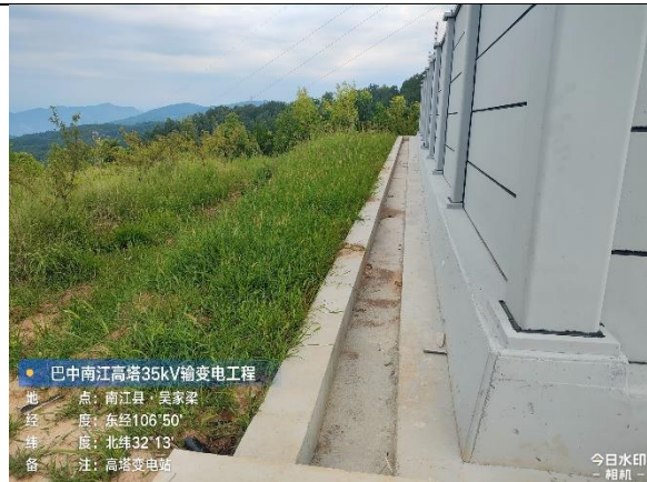
变电站西侧排水沟
