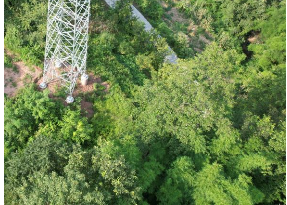
N36 塔 (恢复植被)
