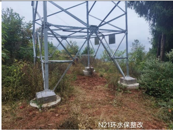
N21 塔 (恢复植被)
