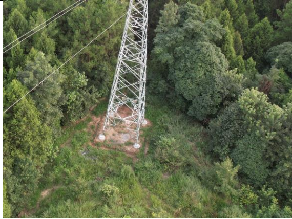
N28 塔 (恢复植被)
