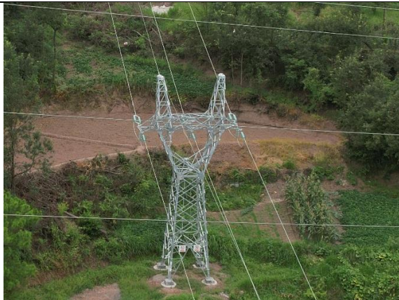
N58 塔 (恢复植被)
