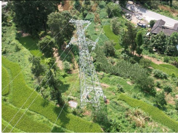
N16 塔 (恢复植被)
