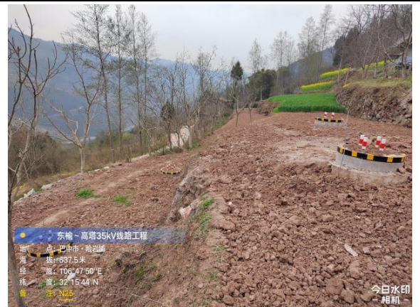
N25塔表土剥离、表土回覆
