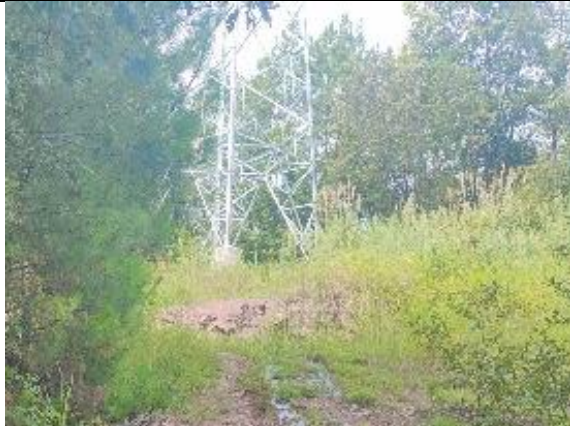
N52 塔 (恢复植被)
