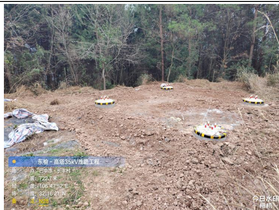
N28塔表土剥离、表土回覆、堆料铺垫塑料布
