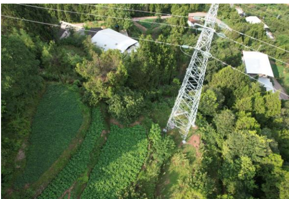
N35 塔 (恢复植被)
