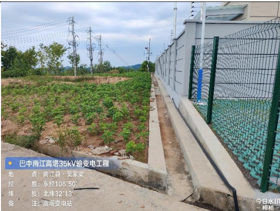
变电站南侧排水沟
