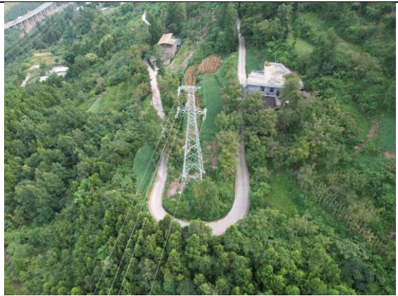
N25 塔 (恢复植被)
