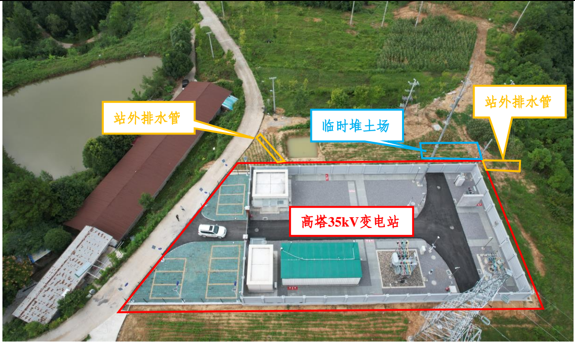
高塔 35kV 变电站
