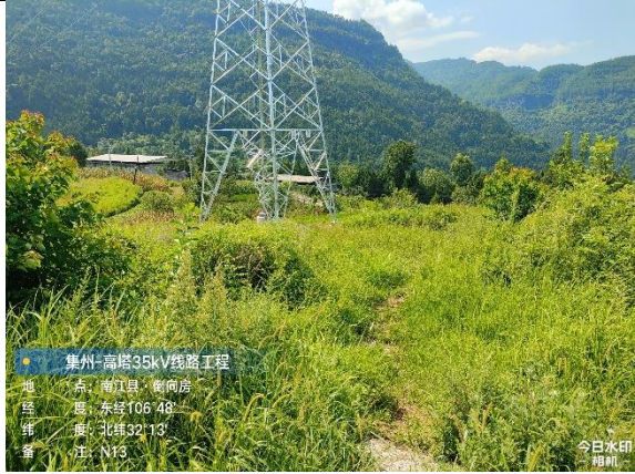
N13 塔 (恢复植被)
