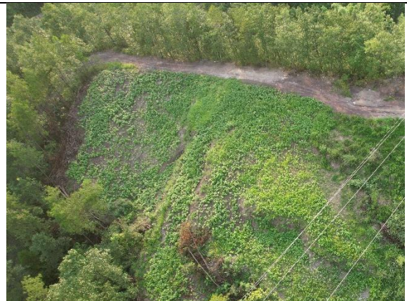
N44 塔旁牵张场 (恢复植被)
