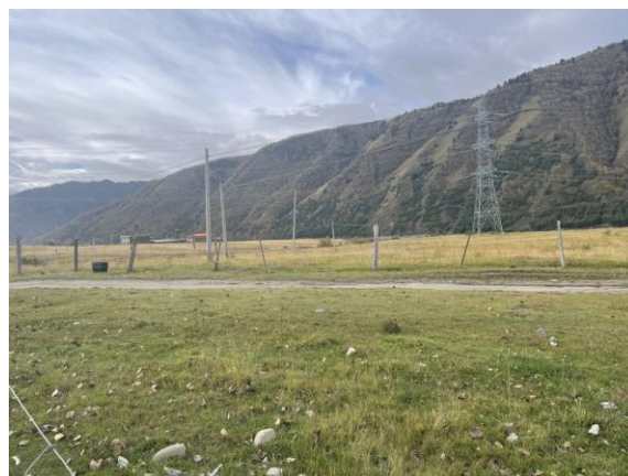
图片 4-2 道孚变电站站址现状 2
