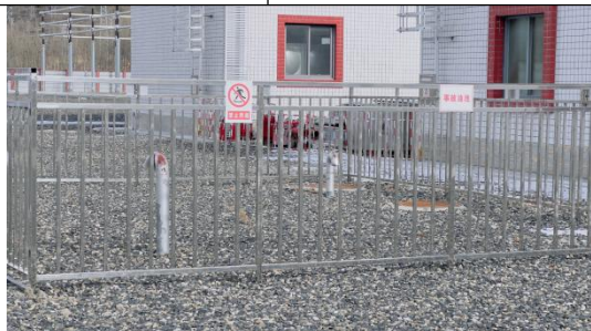
图 3-2 变电站既有事故油池
