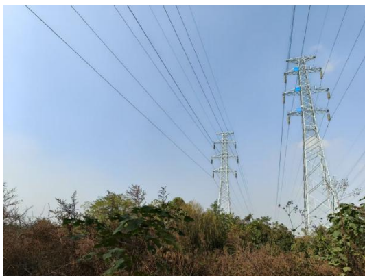
图 37 线路 I、II 同塔双回架设
