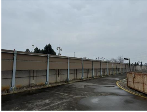
图 4 桃乡变电站西侧围墙处隔声屏障
