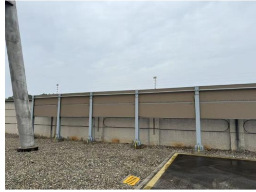
图 5 桃乡变电站西侧围墙处隔声屏障
