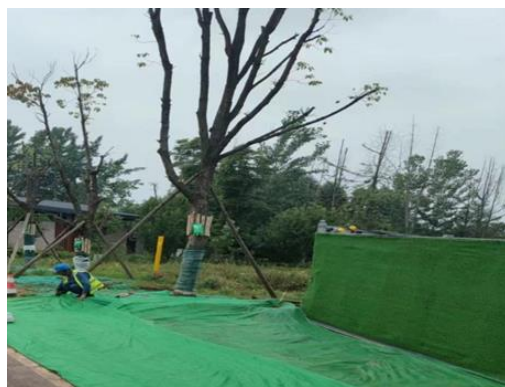
图 22 电缆敷设施工围挡和遮盖
