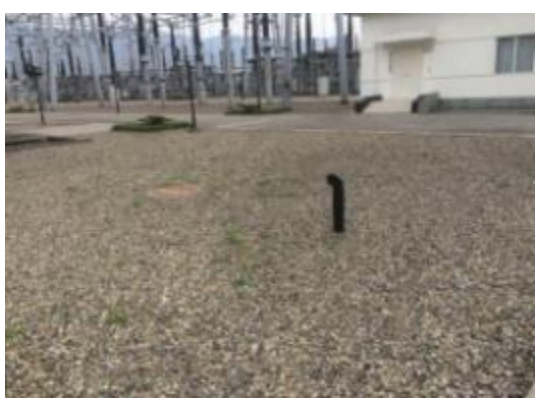
图 3 桃乡变电站事故油池排气孔
