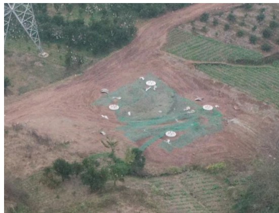
N3 塔基全景
