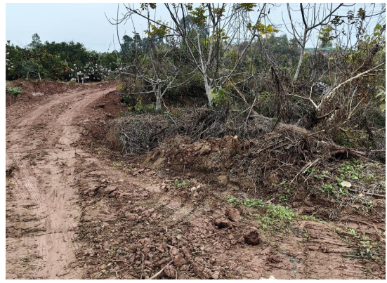
NA1 塔基施工便道侧临时排水沟
