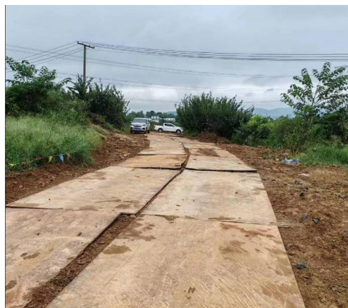
N3 塔基施工便道钢板铺设
