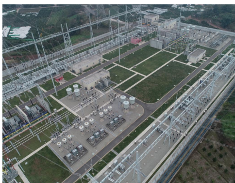
变电站间隔扩建工程—尚未开工
