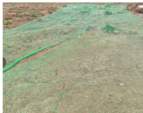
N21 塔基临时遮盖
