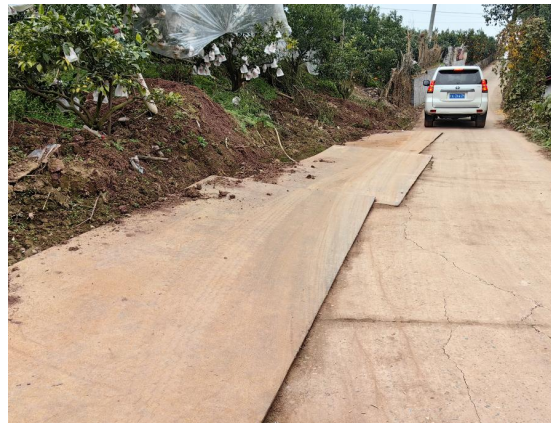
NA1 塔基施工便道拓宽铺设钢板
