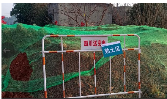
N11 塔基表土堆存保护
