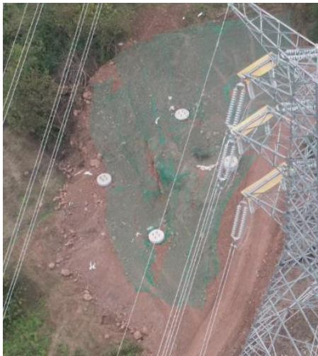
NB1 塔基全景
