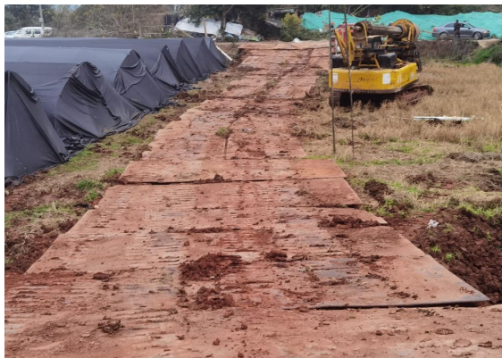
N3 塔基施工便道钢板铺设
