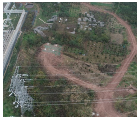
NA1 塔基全景
