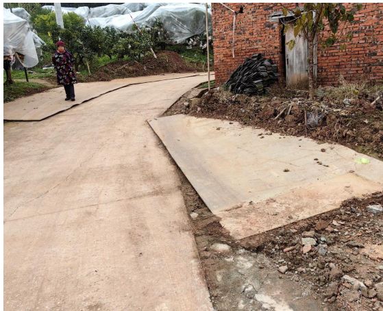
NA1 塔基施工便道拓宽铺设钢板
