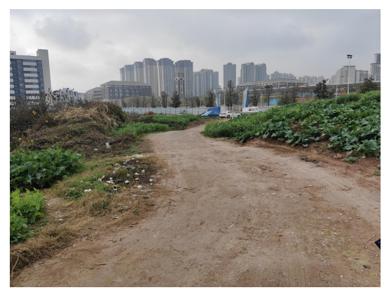
松柏 220kV 变电站-进站道路
