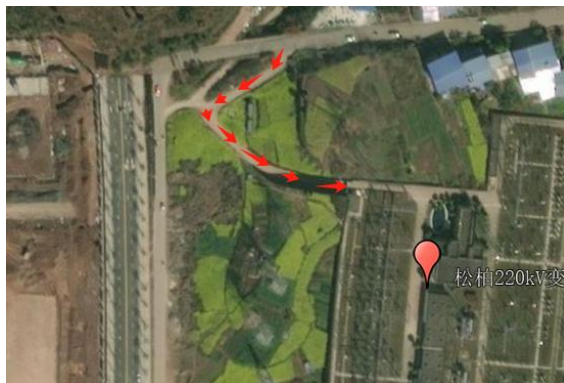
松柏 220kV 变电站-进站道路（破坏前）
