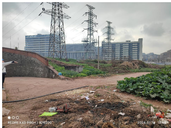
松柏 220kV 变电站-进站道路
