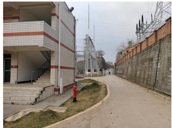
松柏 220kV 变电站-站内道路
