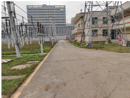
松柏 220kV 变电站-站内道路
