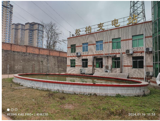
松柏 220kV 变电站-水池现状
