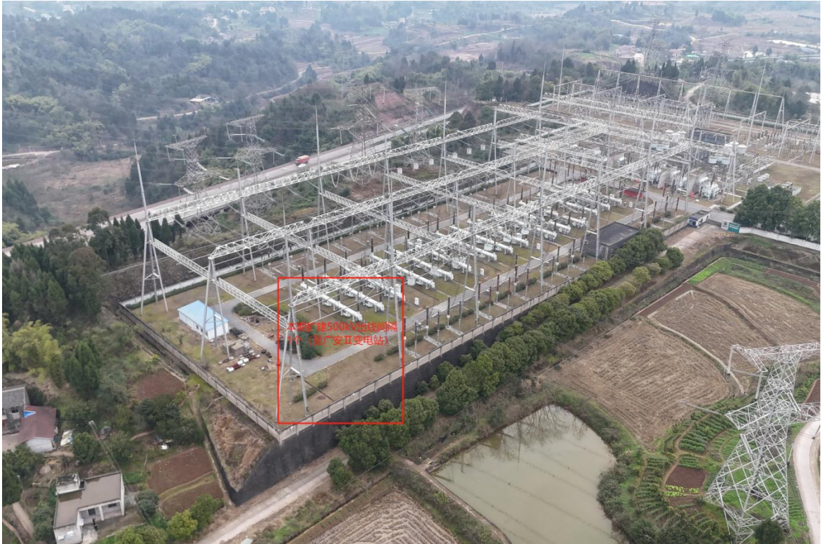
图 3.1-4 黄岩500kV 变电站本期间隔扩建侧现状照片
