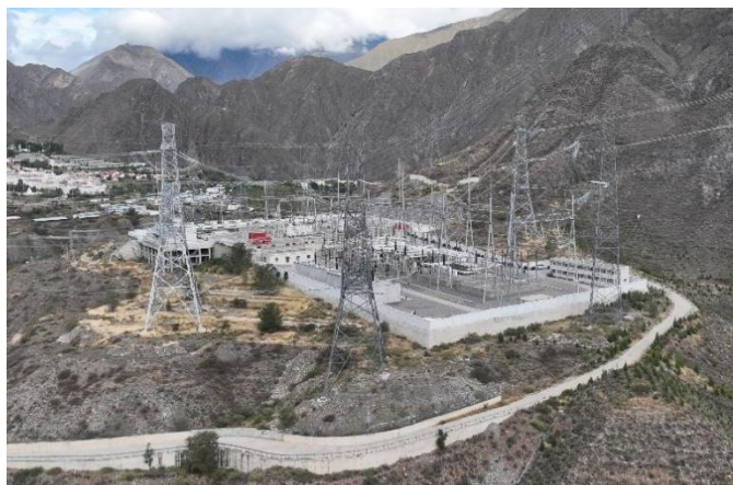
图 3-3 色尔古 500kV 变电站站址现状
