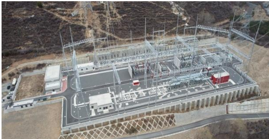
图 3-2 马尔康 500kV 变电站站址现状
