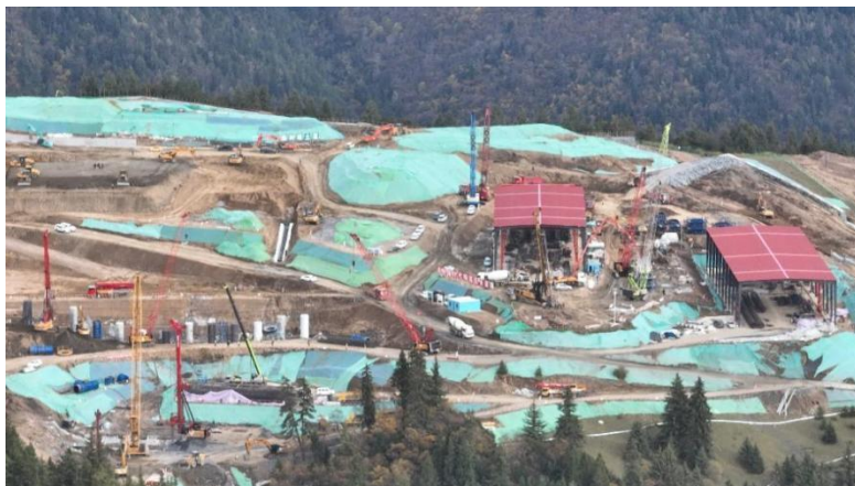
图 3-1 阿坝 1000kV 变电站站址现状
