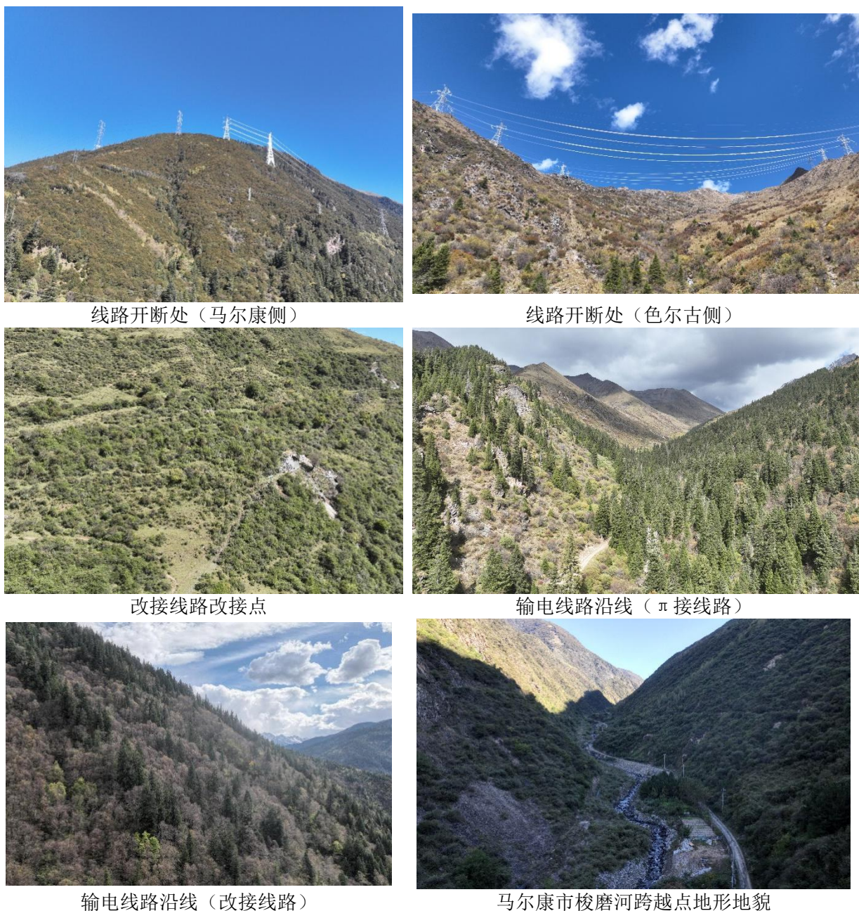
图 4-2 输电线路沿线地形地貌典型照片
