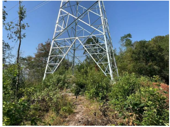
复兴至盖家坪 \pi 入玛瑙 220kV 线路工程 N5 现场照片
