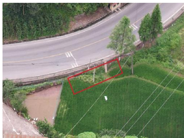
复兴至盖家坪 \pi 入玛瑙 220kV 线路工程 N3~N4 跨越施工临时占地
