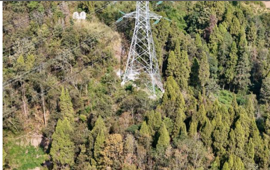
复兴至盖家坪 \pi 入玛瑙 220kV 线路工程 N6 现场照片
