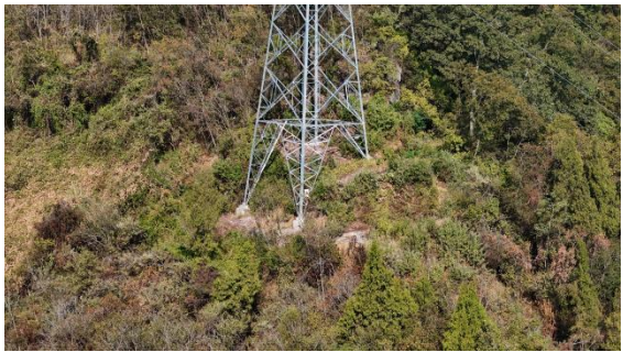
复兴至盖家坪 \pi 入玛瑙 220kV 线路工程 N7 现场照片
