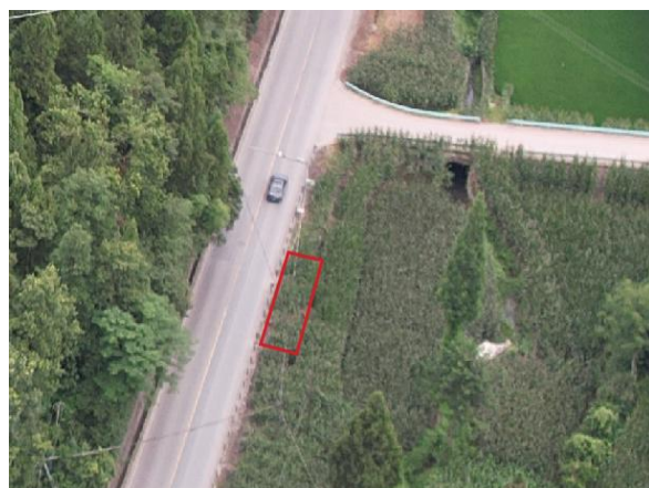
复兴至盖家坪 \pi 入玛瑙 220kV 线路工程 N2~N3 跨越施工临时占地
