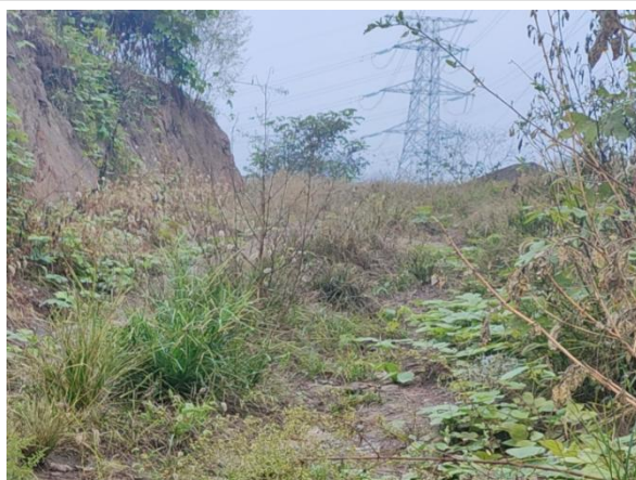
复兴至盖家坪 \pi 入玛瑙 220kV 线路工程 N1 汽运道路现场照片
