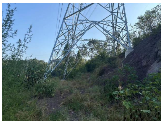
复兴至盖家坪 \pi 入玛瑙 220kV 线路工程 N2 现场照片
