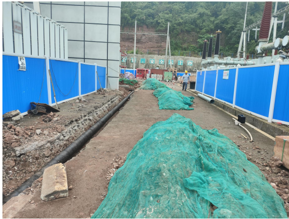
施工过程中临时苫盖
