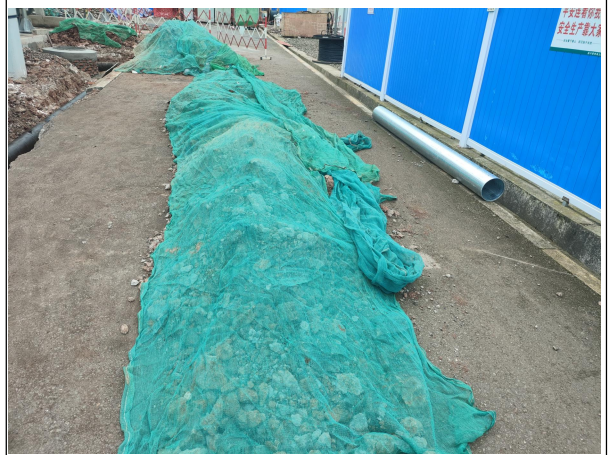
施工过程中临时苫盖
