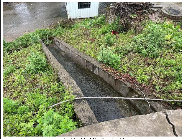
站外截排水现状
