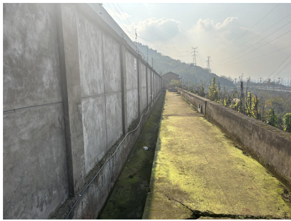
站外截排水现状
