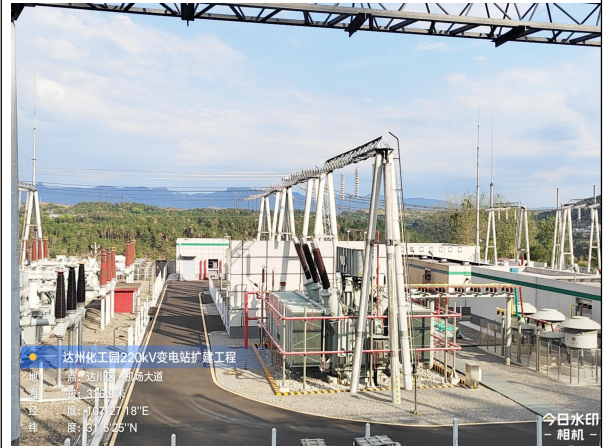
施工过程中照片
