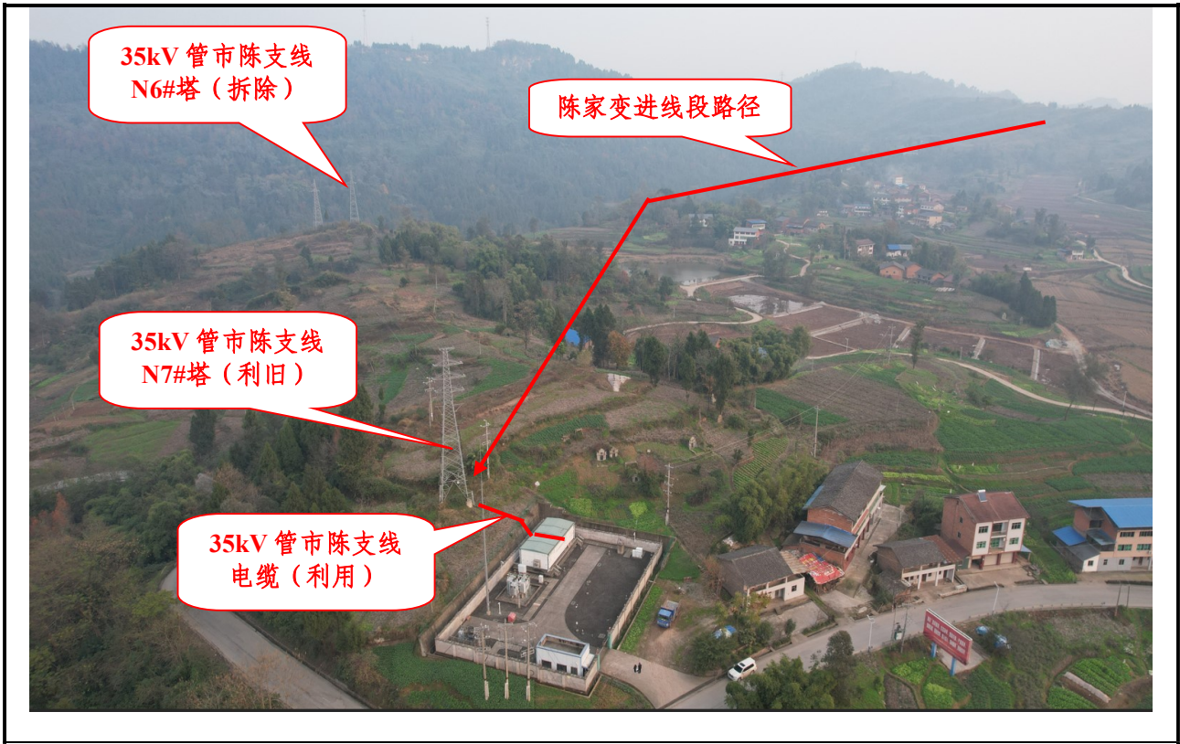
陈家 35kV 变电站及进线现状
