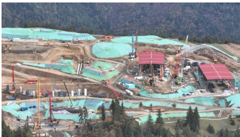
图 3-1 阿坝 1000kV 变电站站址现状
