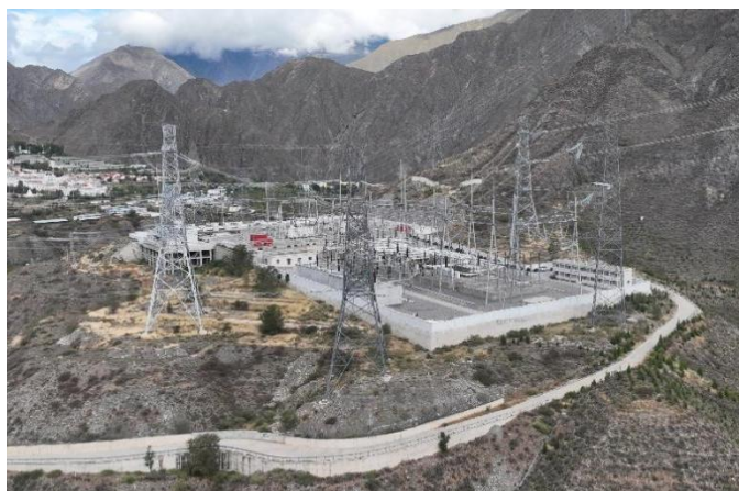
图 3-4 色尔古 500kV 变电站站址现状
