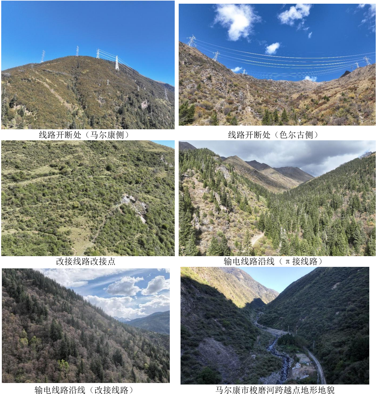
图 4-4 输电线路沿线地形地貌典型照片
