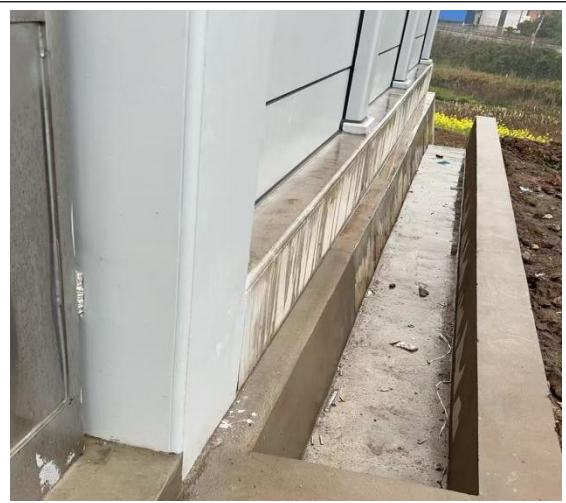
变电站站外排水沟照片（2025. 3. 12）
