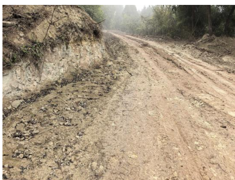
道路临时排水沟
