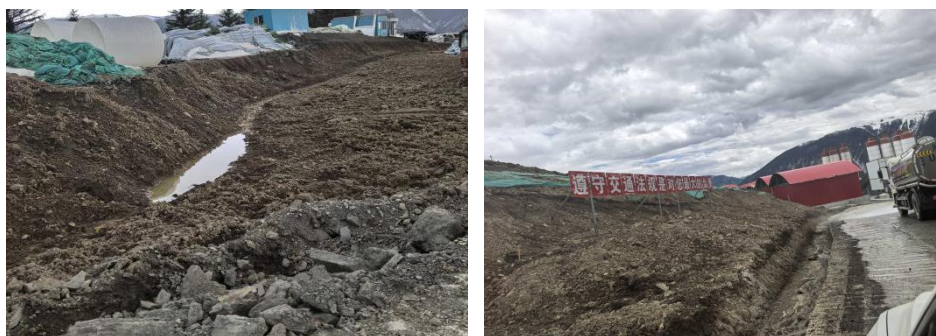
场内临时排水沟
