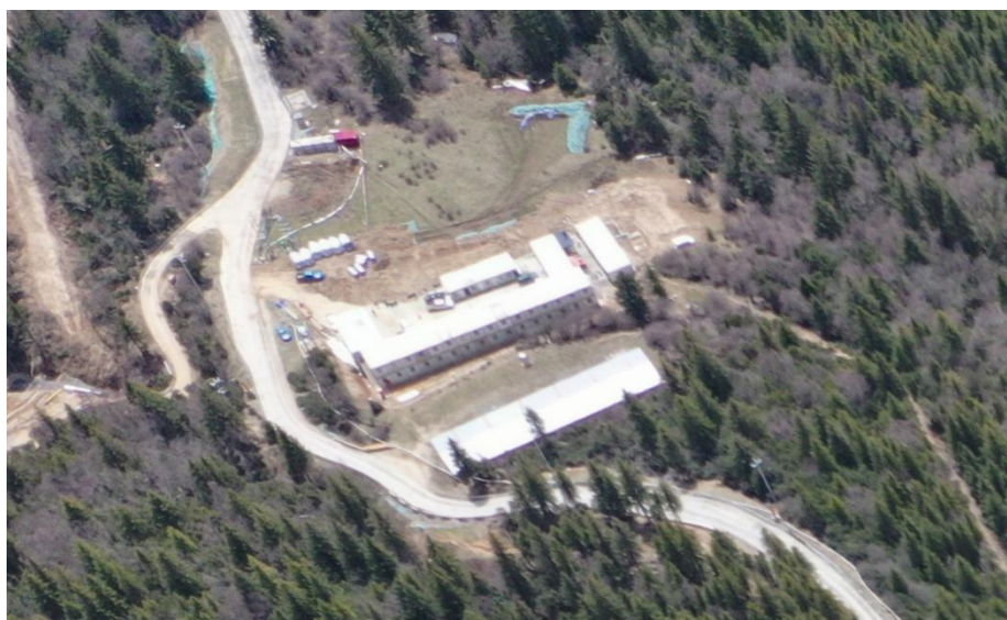
新建路施工生产生活区无人机影像
