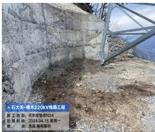
图 4.4-10 石大关-槽木 N 24 号塔位堡坎
