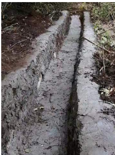
图 4.4-9 石大关-槽木 N11 号塔位排水沟及护坡
