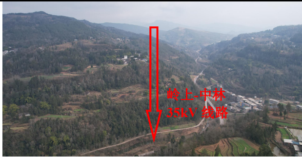
童家坝跨 S203 沿线地形地貌
