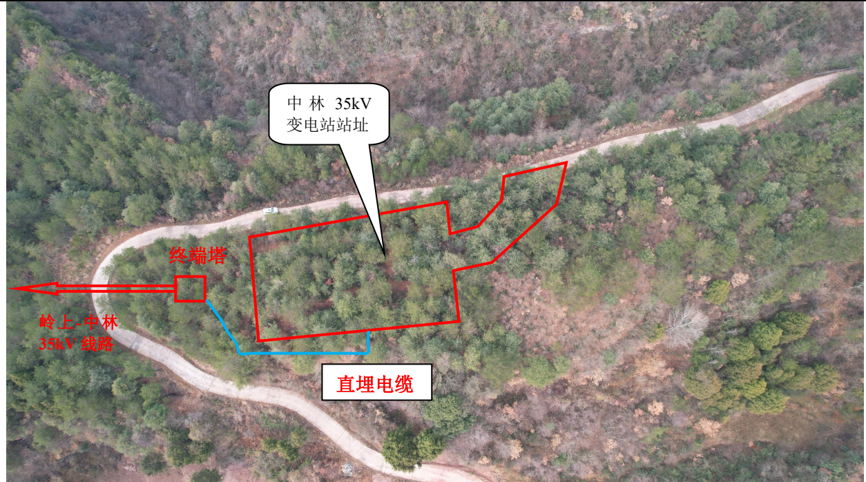
中林 35kV 变电站站址现状
