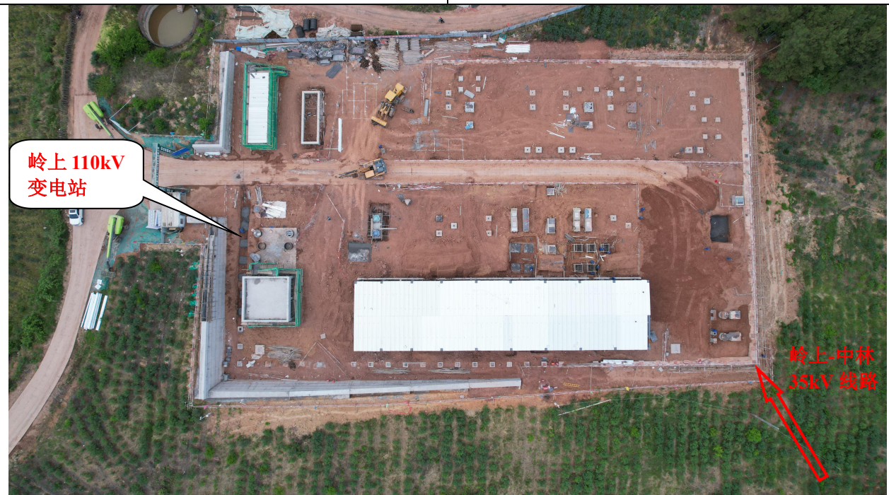
岭上 110kV 变电站现状
