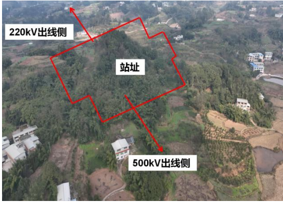
图 4-1 宜宾南变电站站址现状 1
