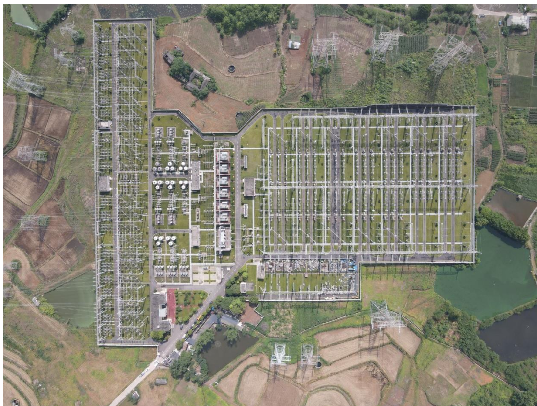
图 4-1 本次拟扩建变电站所在区域地形、地貌
