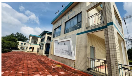
主控通信综合楼
