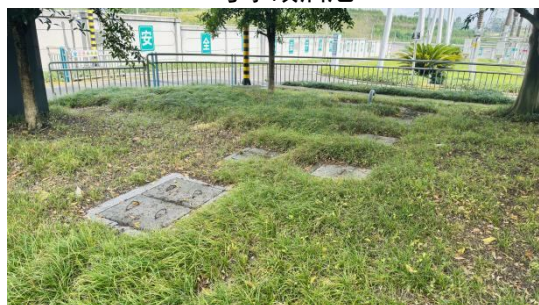
生活污水处理设施
