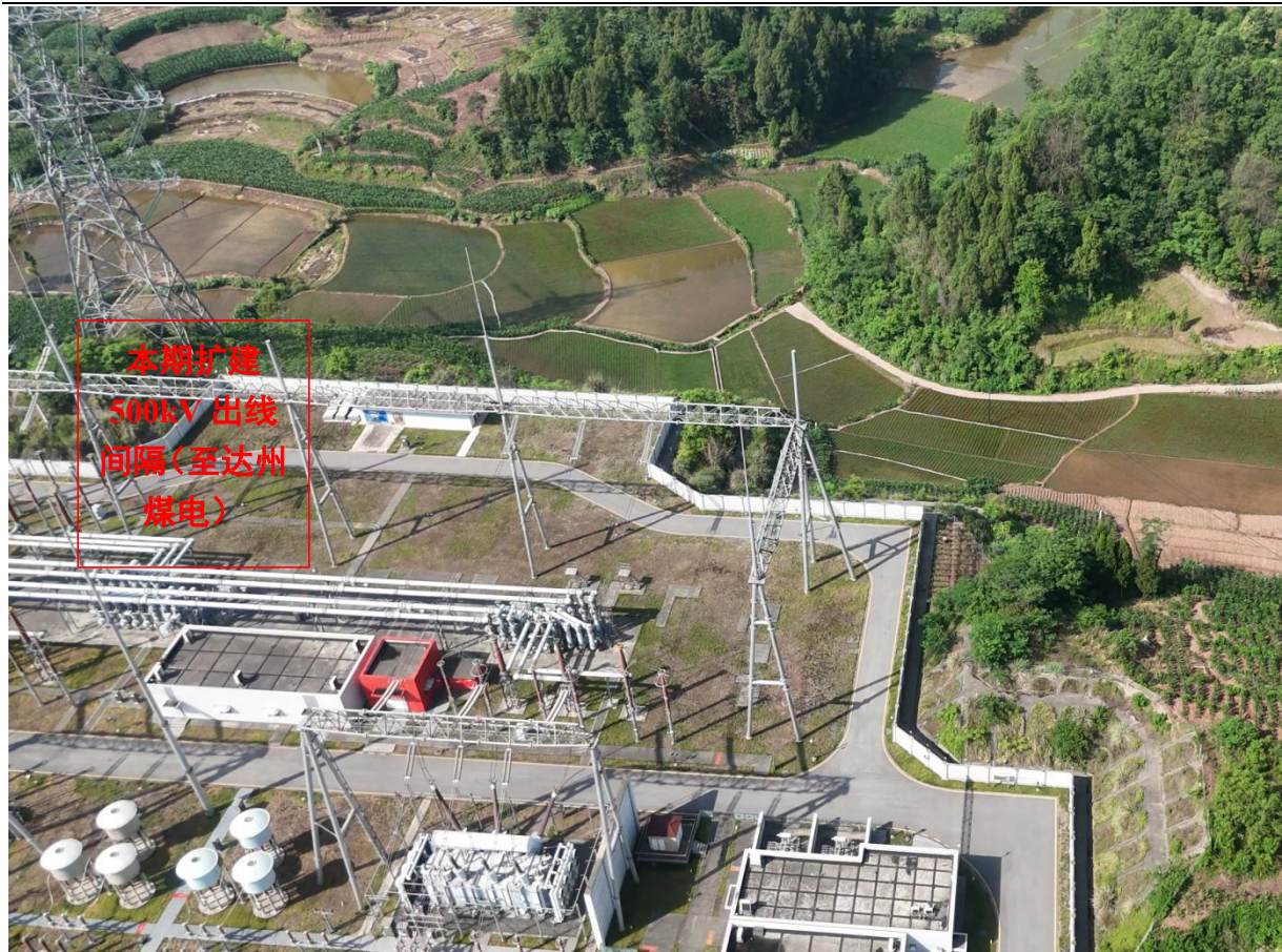
图 3.1-7 玛瑙500kV 变电站本期间隔扩建侧现状照片
