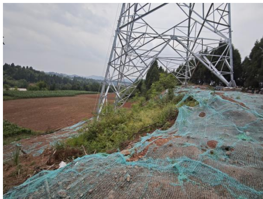
N19 塔基密目网苫盖
