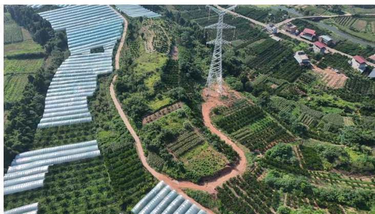
图2 施工道路无人机航拍
