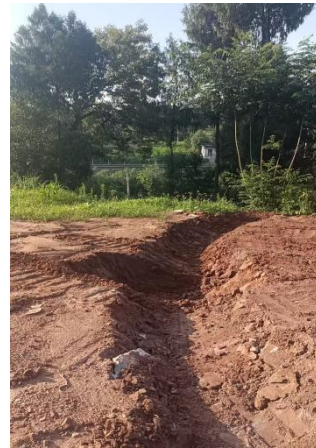
道路临时排水沟
