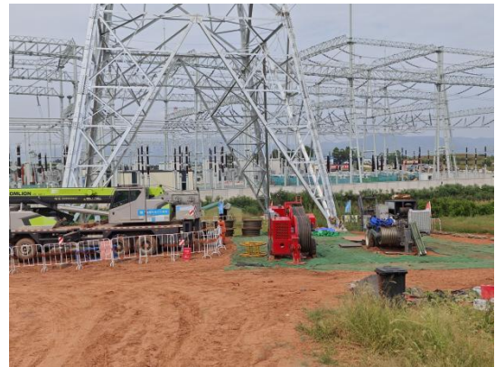
N122 塔基密目网苫盖
