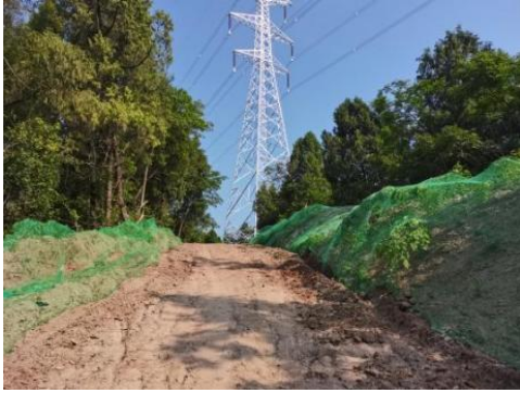
N017 道路表土苫盖、临时排水沟
