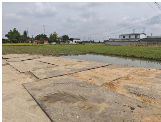
施工道路铺设钢板
