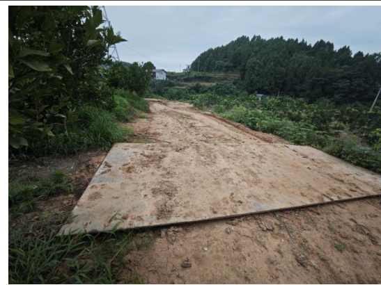
道路铺设钢板
