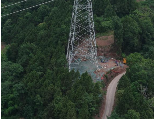
N005 塔基密目网苫盖
