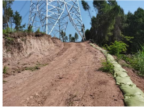
N023 施工道路土袋拦挡
