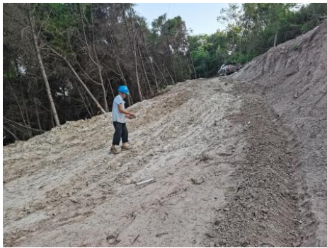
N044 施工道路开挖临时排水沟、撒播草籽
