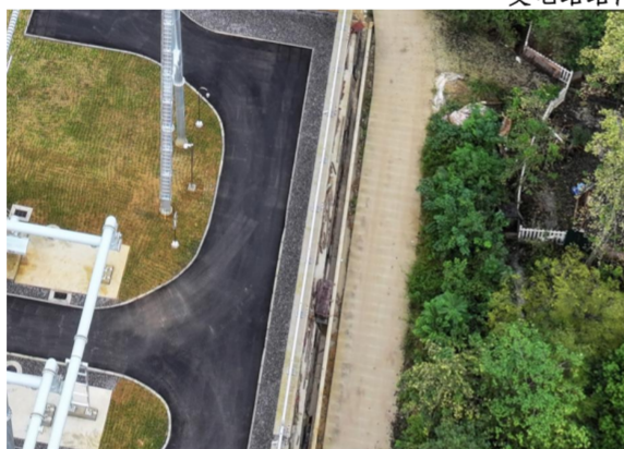
变电站外排水沟(2025.9)
