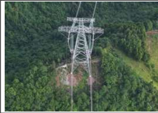
N5453 塔基区植被恢复 (2025.7)
