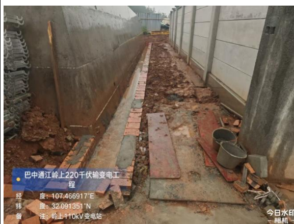
浆砌石排水沟
