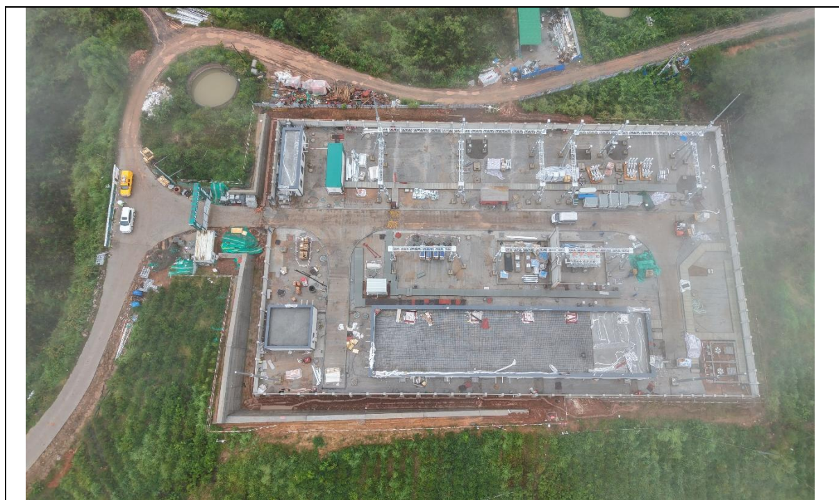
岭上 110kV 变电站施工情况
