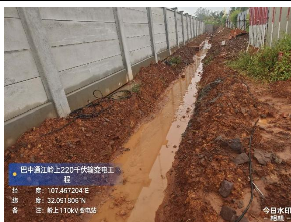
临时排水沟（永临结合）
