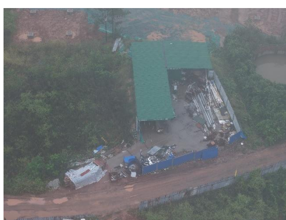
钢筋、木工加工场
