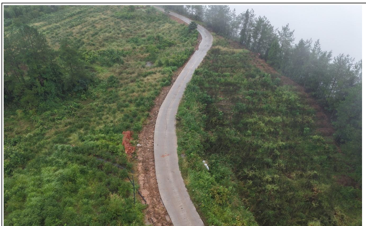
岭上 110kV 变电站引接道路现状
