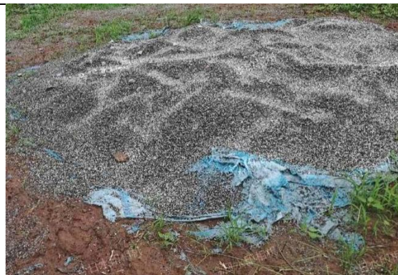
通杨 \pi 接线路 N8 塔临时铺垫
