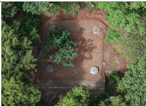
文龙二线 \pi 接线路 N14 塔挡土墙、覆土、土地整治、临时排水沟
