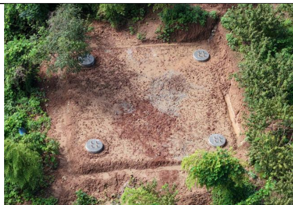
文龙二线 \pi 接线路 N12 塔覆土、土地整治、临时排水沟
