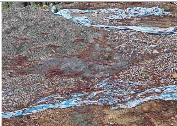
杨南改接线路 N23 塔临时铺垫
