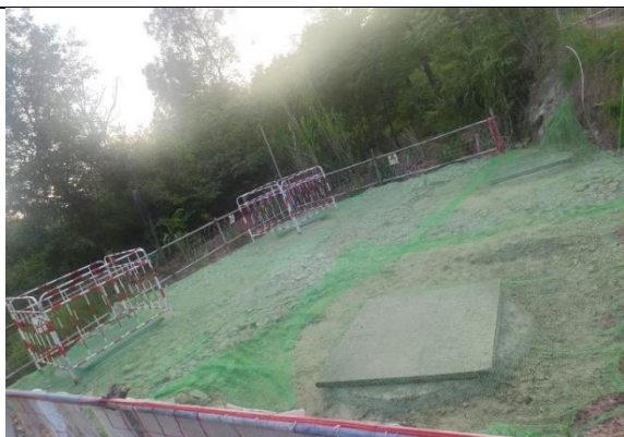
文龙二线 \pi 接线路 N11 塔临时遮盖
