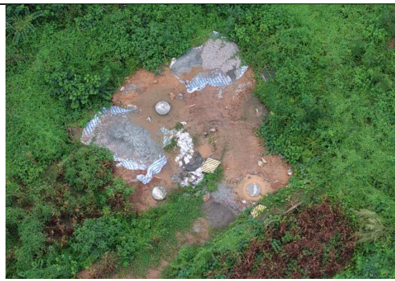
杨南改接线路 N23 塔覆土、土地整治、临时铺垫
