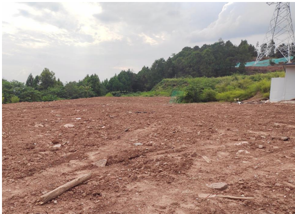
站址西侧临时场地拆除后覆土、土地整治
