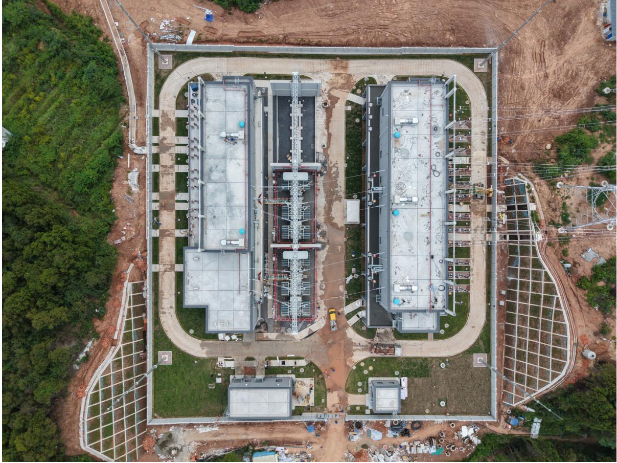
曾口 220kV 变电站施工情况
