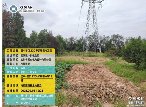
巴中~曾口 I 回 N11 塔汽运道路土地整治及恢复
