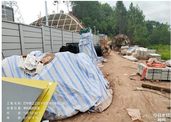
入口施工临时场地临时遮盖
