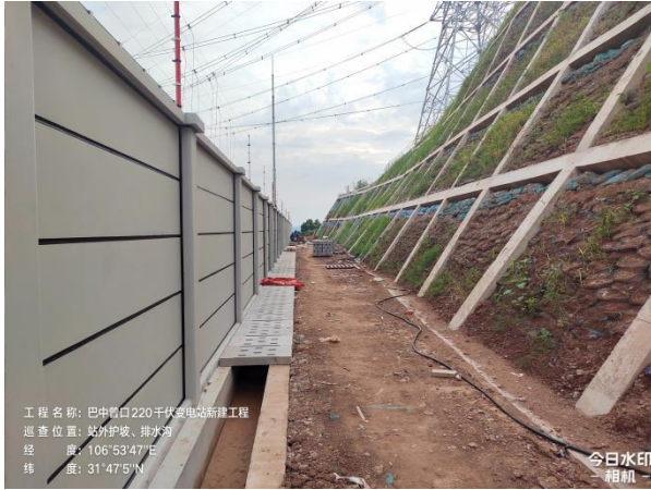
站外排水沟及护坡
