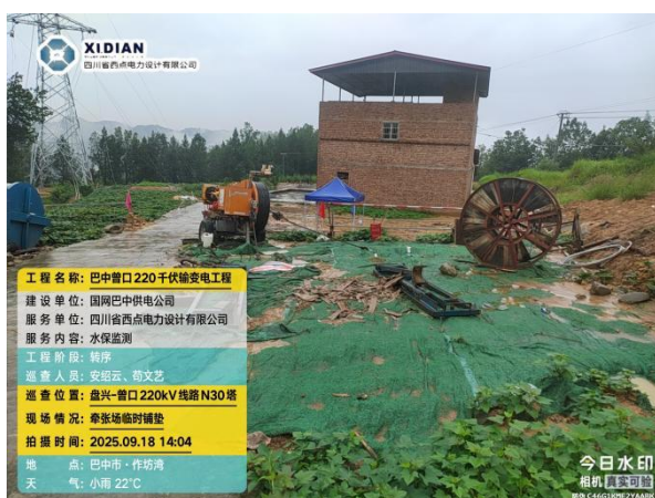
牵张场临时铺垫
