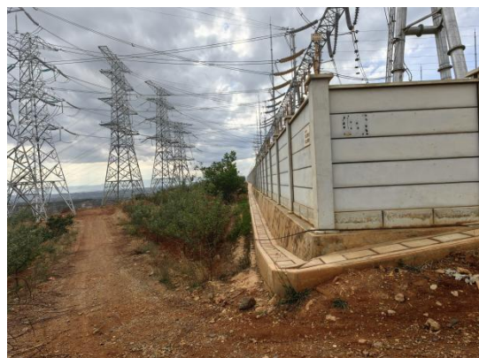
电缆通道现状
