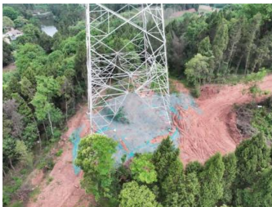
图8-8 塔基区密目网苫盖
