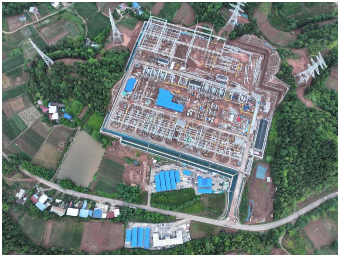
图3-2 变电站无人机航拍
