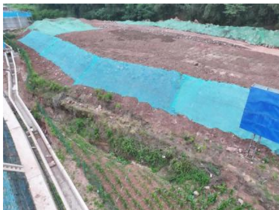
图8-5 变电站开挖堆土密目网苫盖
