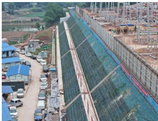
图8-6 变电站植生带护坡
