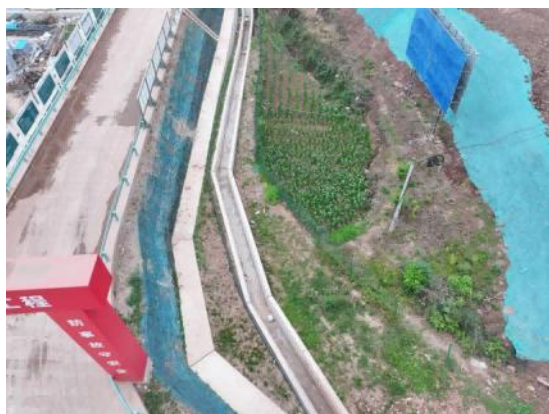
图8-3 变电站进站道路两侧完成复耕
