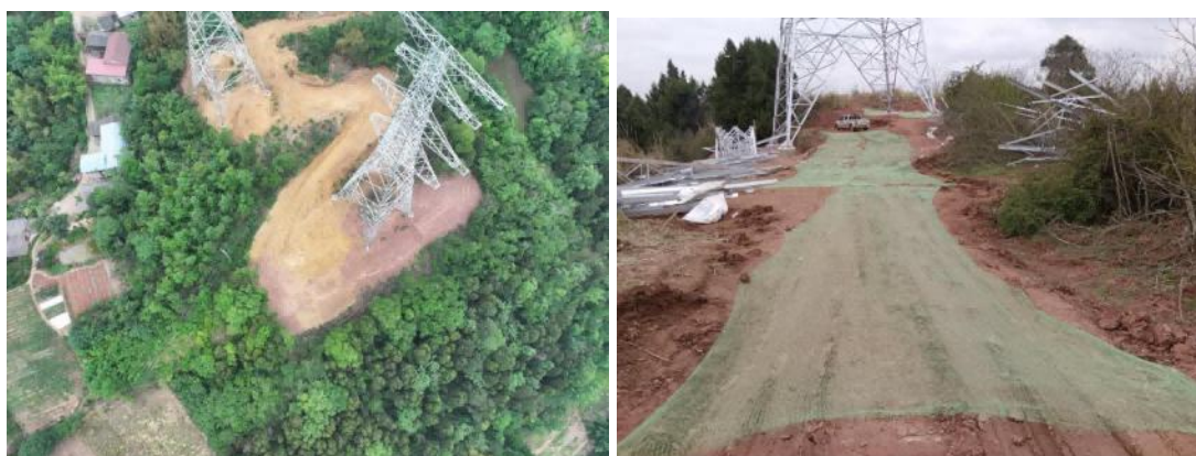
图6-3 NA43塔基重新土地整治 图6-4 NC110塔基采用密目网进行垫护
