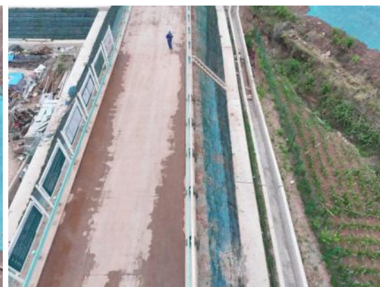
图8-4 变电站站区排水沟布设
