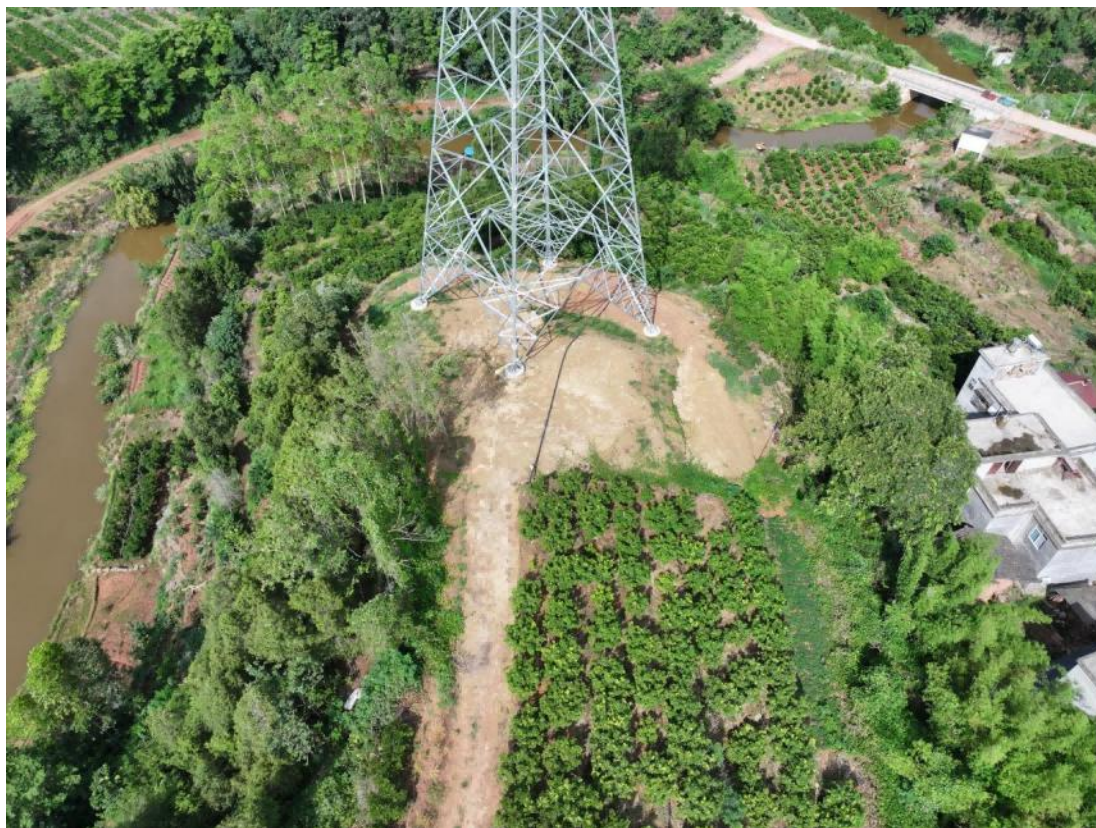
图3-4 塔基区无人机航拍
