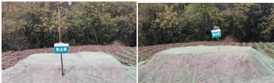
图6-1、图6-2 施工前进行表土剥离，并单独堆存养护
