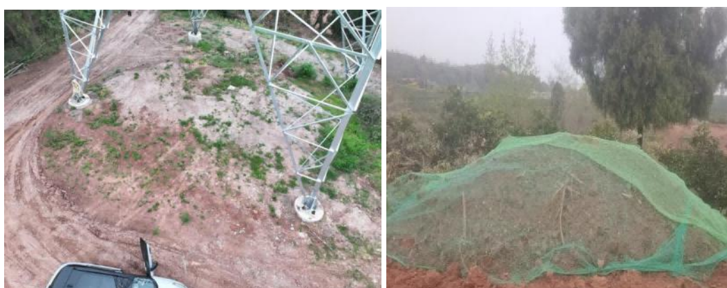
图6-5 NA46塔基进行了彻底清理 图6-6 NC138塔基堆土采用密目网进行苫盖
