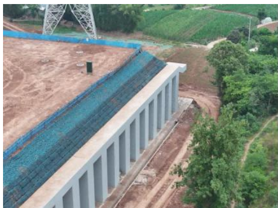
图8-7 变电站植生带护坡布设
