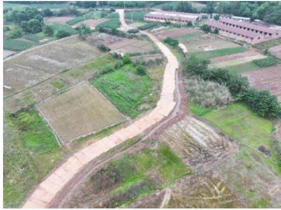
图8-12 施工道路钢板铺设
