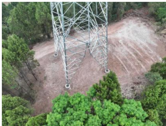
图8-10 塔基区完成场地平整
