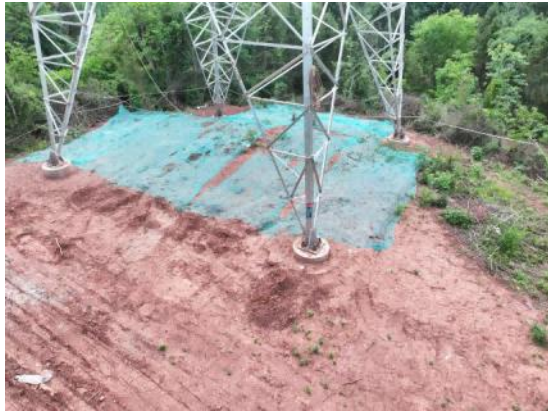
图8-11 塔基区密目网苫盖
