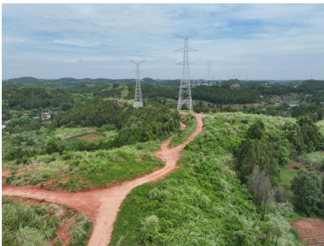
图3-3 施工道路无人机航拍
