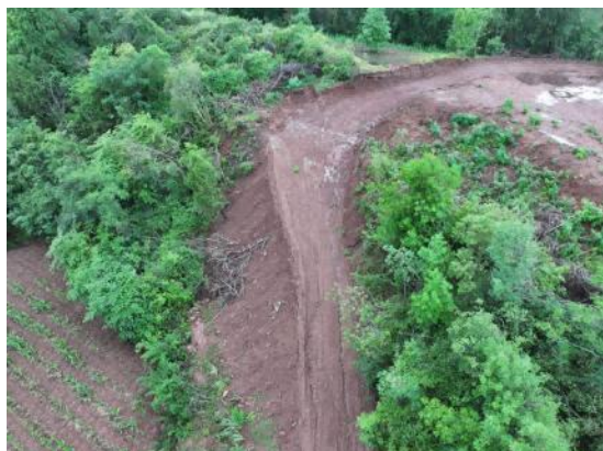
图5-1 NC20塔基基面存在侵蚀沟
