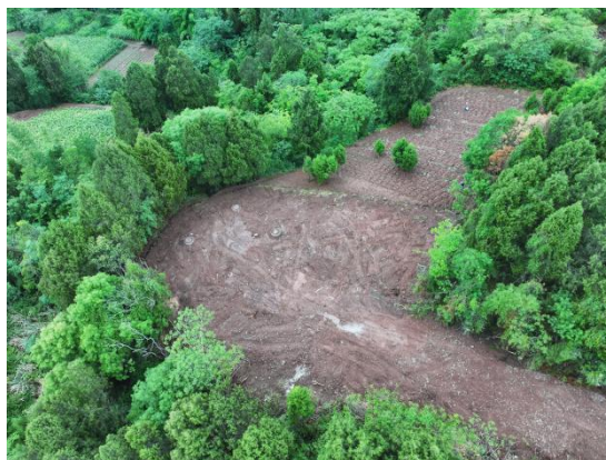
图8-2 塔基区施工完成后进行场地整治
