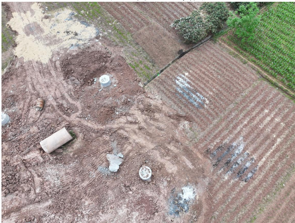
图3-5 塔基区无人机航拍
