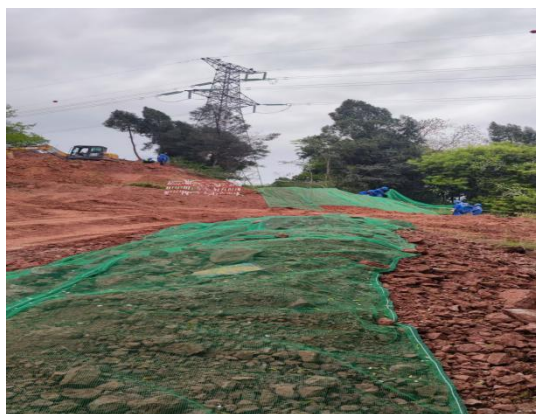
图8-6 塔基区开挖堆土密目网苫盖
