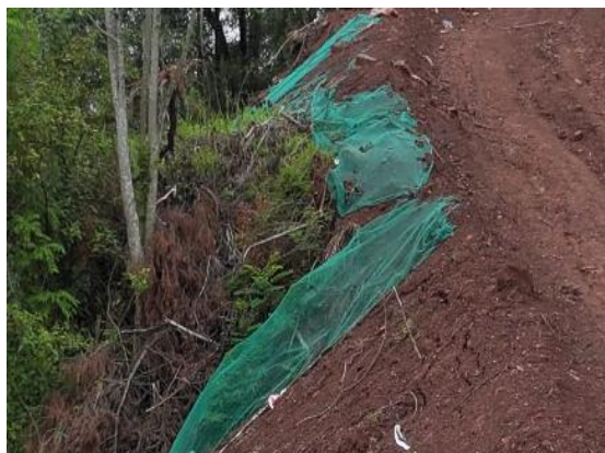
图8-1 施工便道边坡采用密目网苫盖
