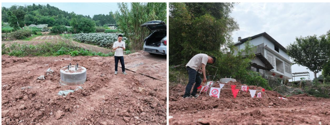
图3-6、图3-7 施工人员对现场采用无人机航拍和测钎监测
