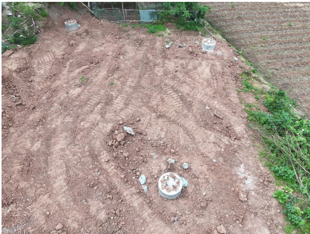
图3-4 塔基区无人机航拍
