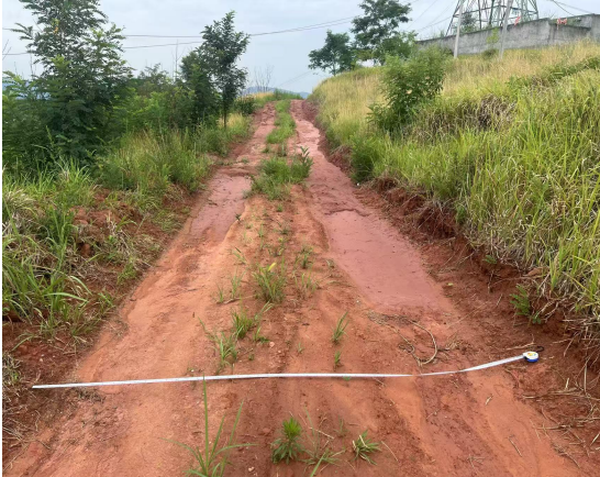
施工便道宽度测量现场照
