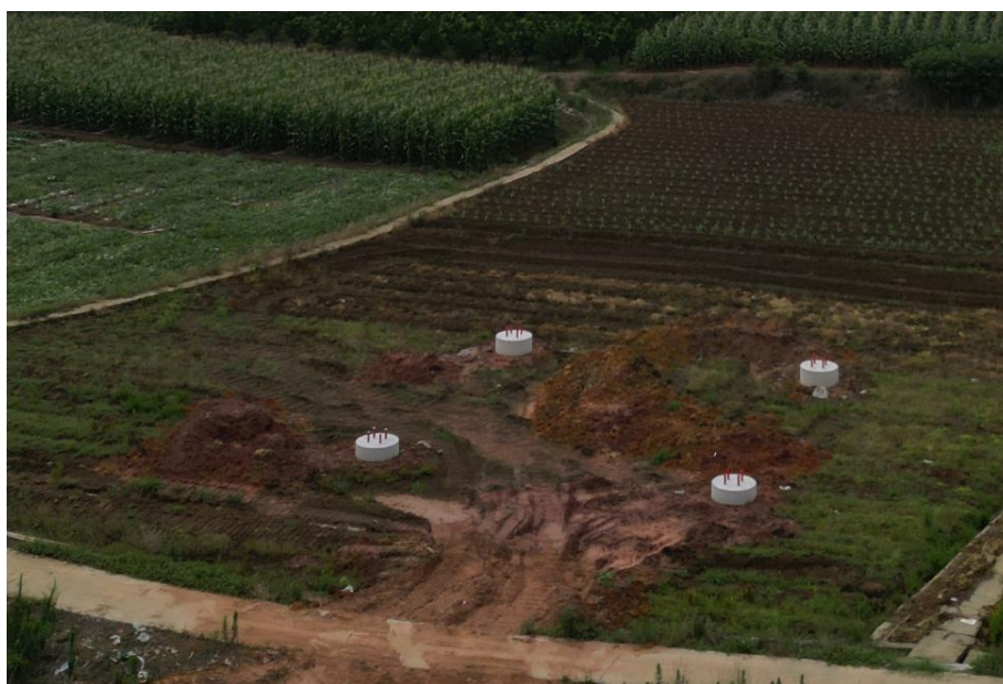
NB03 塔基开挖堆土未苫盖、拦挡、平整
