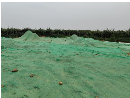
图8-1 塔基区钢板铺设
