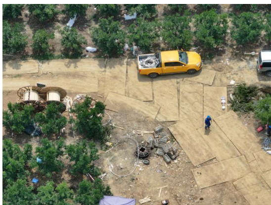
图8-3 塔施工便道钢板铺设
