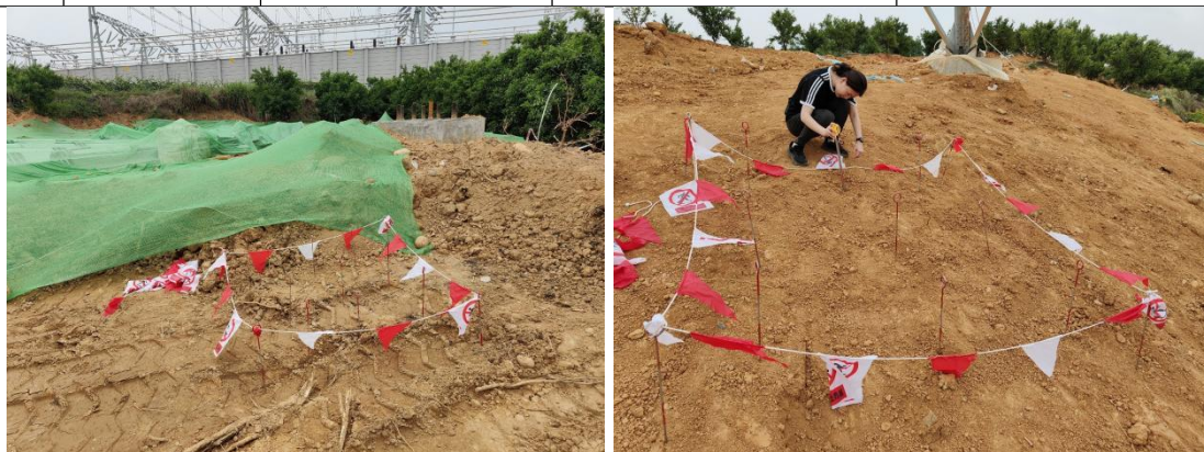
图3-3、图3-4 对塔基区布设监测点位
