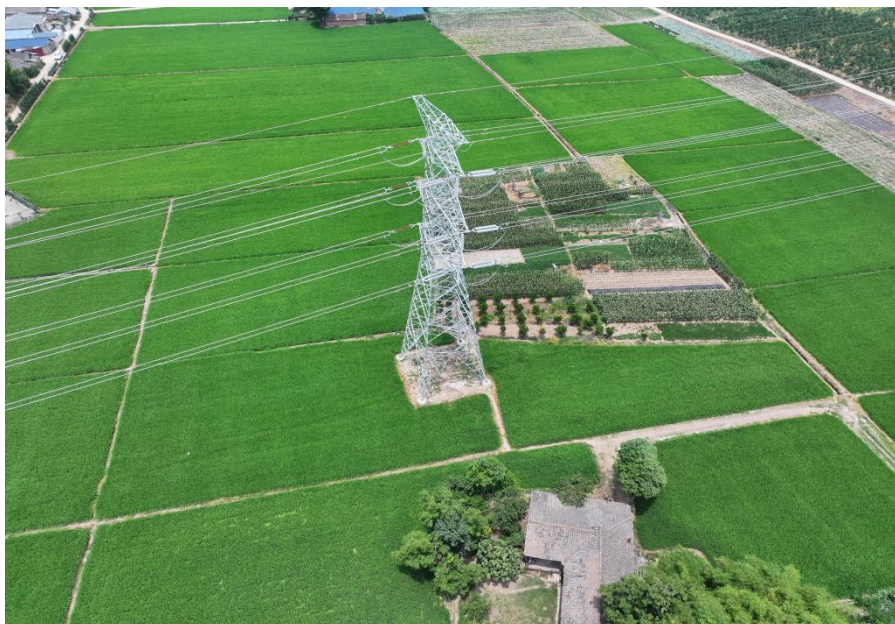
图3-1 塔基区无人机航拍
