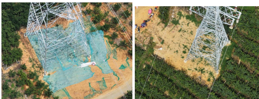
图6-3、塔基区采用密目网苫盖
