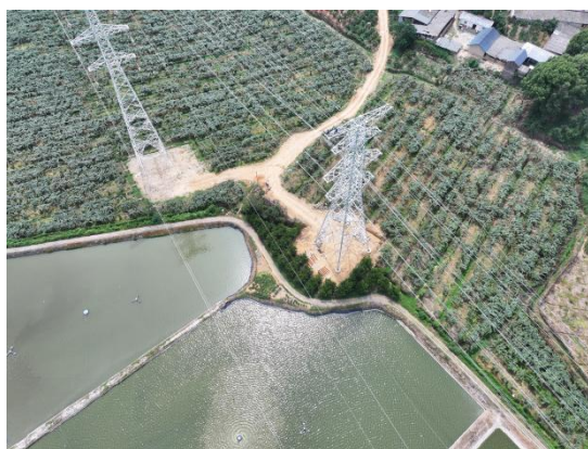
图8-9 塔基区完成土地整治工作
