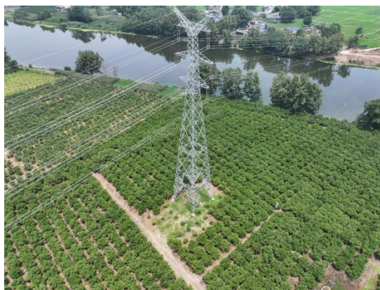
图8-4 塔基区施工场地复耕
