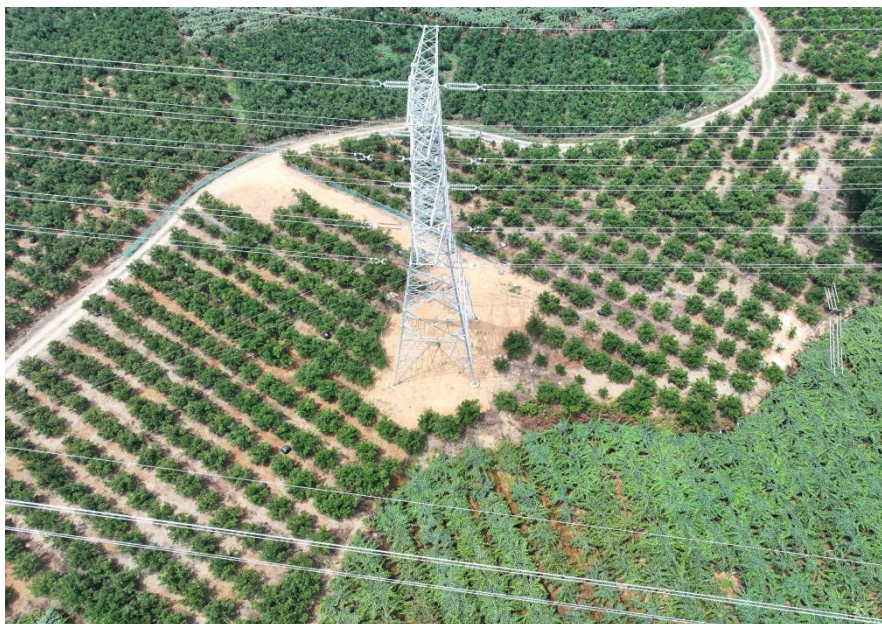
图3-2 塔基区无人机航拍
