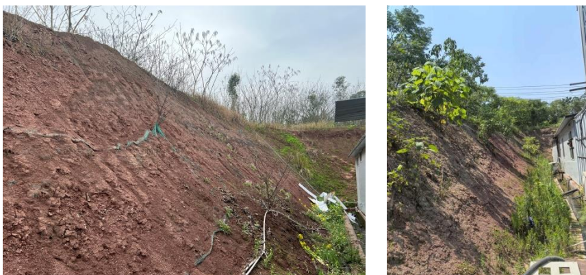
边坡整改前后对比照片（整改后效果仍不达标）
