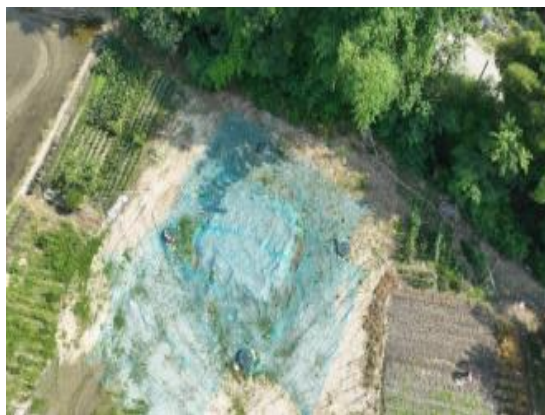
图8-6 基础完成塔基区已密目网苫盖
