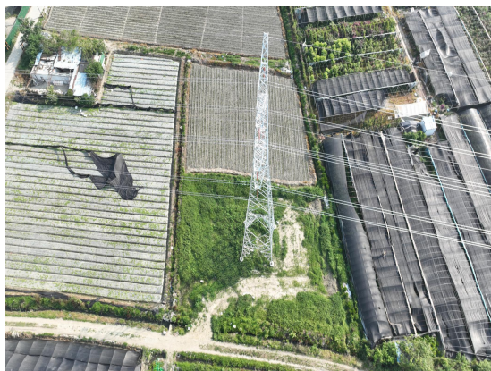
图8-5 架线塔基区已恢复植被
