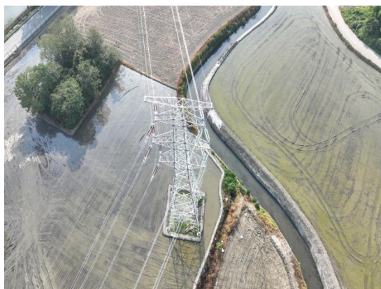
图8-4 架线塔基已恢复原始地貌
