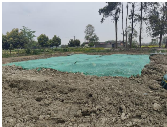
图8-2塔基区施工完成后进行场地整治
