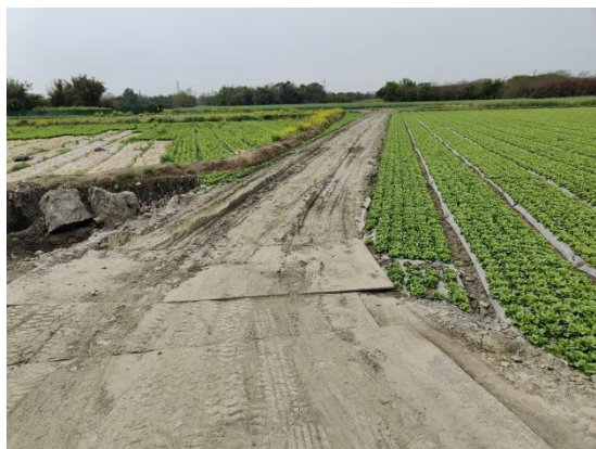
图8-1 塔基区钢板铺设
