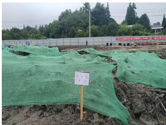
图8-3 变电站区表土剥离后密目网苫盖
