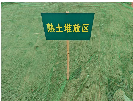
图8-1塔基区表土剥离及保护
