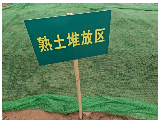
图8-3变电站区表土剥离后密目网苫盖
