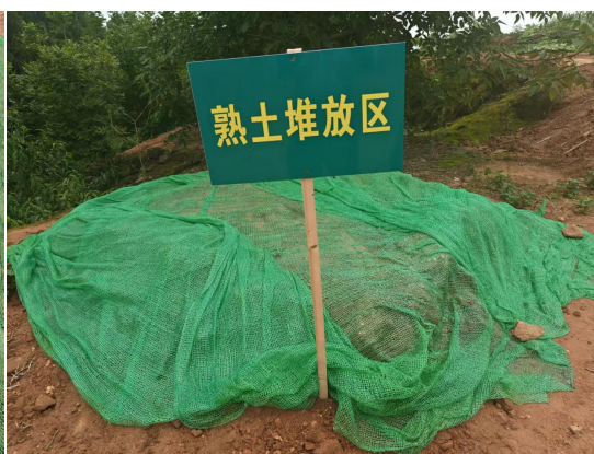
8-2塔基区表土剥离及保护
